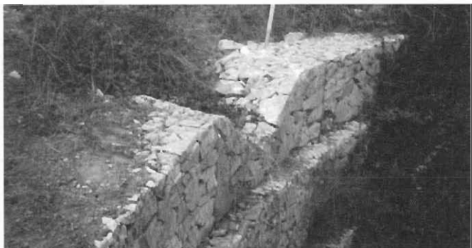
Este muro de contención ha conseguido parar la cárcava y ahora sirve para controlar el desagüe
