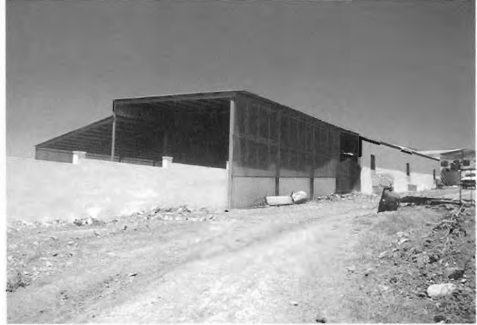
Cerramientos en el área de reposo
