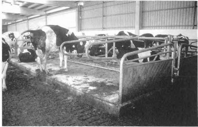
Vaca defecando. El diseño del cubículo hace que el estiércol caiga al pasillo
