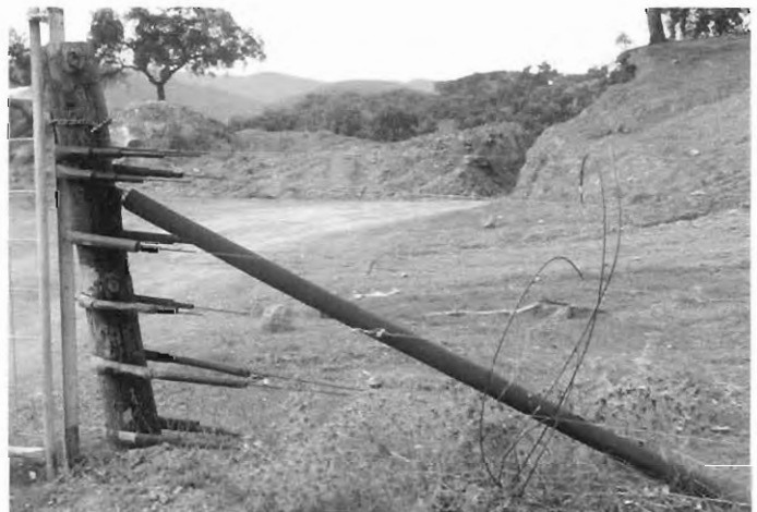
Detalle de un poste de amarre en una cerca de tensión con hilos electrificados. El aislado de los hilos se realiza por medio de tubos de plástico
