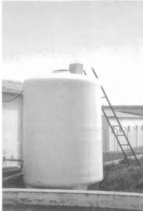
Depósito de agua clorada para las tareas de limpieza de la explotación
