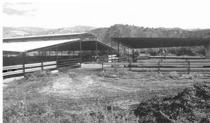
Cercado en explotación vacuna realizado con perfiles metálicos
