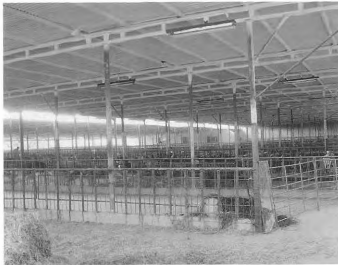
Espuma aplicada en cubierta para el aislado térmico del área de reposo
