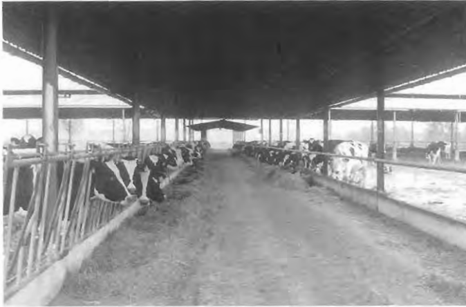
Pasillo de alimentación con murete comedero con y sin cornadiza
