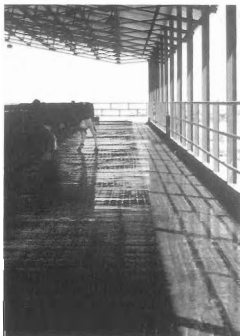
Detalle de pasillo con terminación superficial antideslizante
