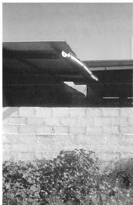
Detalle de un cercado de obra realizado con bloques de hormigón.
