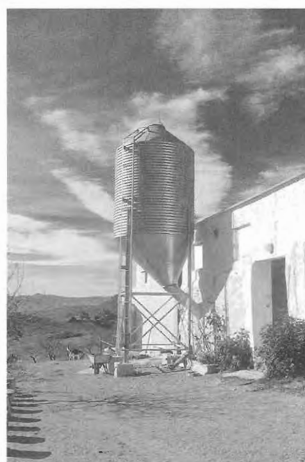
Silo vertical de chapa galvanizada para el almacenamiento de granos
