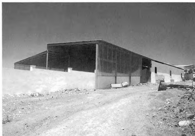
Cerramientos en el área de reposo
