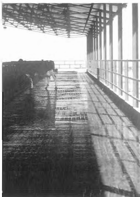
Detalle de pasillo con terminación superficial antideslizante:
