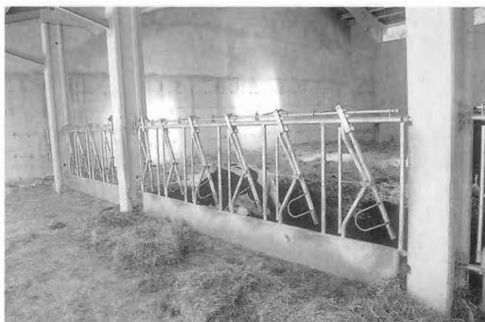
Alojamiento para novillas en estabulación libre y cama caliente
