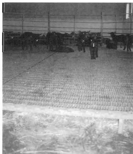
Inadecuado diseño de alojamiento para cabritos sobre suelo emparillado, ya que la solera, al contar con paja, no puede ser limpiada ni tener un drenaje de líquidos correcto, lo que puede provocar problemas higiénicos y sanitarios.
