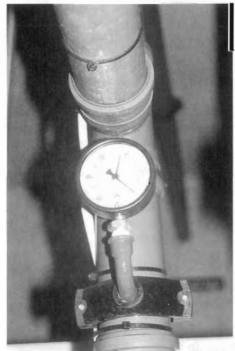
Vacuómetro para medir el nivel de vacío en el interior de las conducciones
