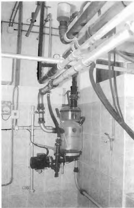
Equipo de ordeño directo a tanque, se puede apreciar la unidad final
