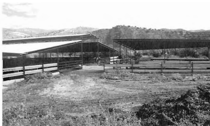
Cercado en explotación vacuna realizado con perfiles metálicos
