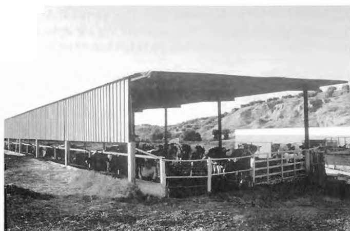
Cerramiento en fachada norte realizado con chapa galvanizada
