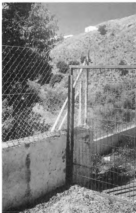
Cercado mixto realizado de obra y malla de torsión
