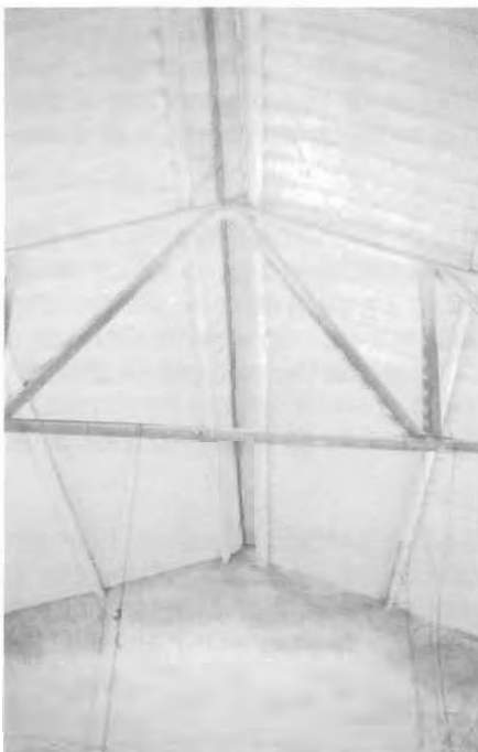
Aislante proyectado en cubierta para mejorar las condiciones de aislamiento
