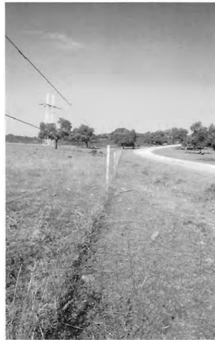
Postes separadores para mantener la distancia entre los hilos del cercado
