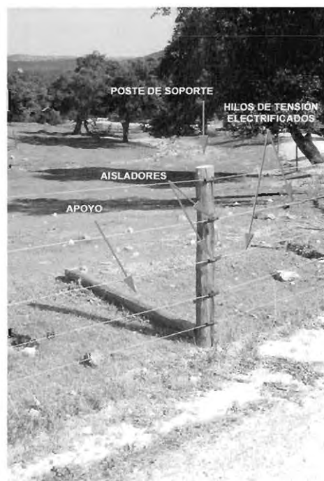
Componentes de un cercado eléctrico
