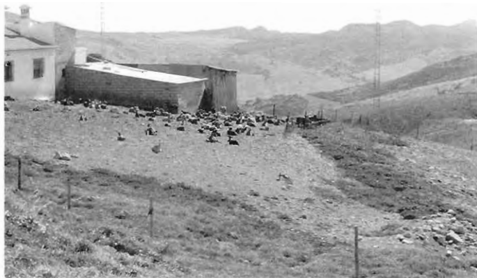
En esta explotación el suministro eléctrico se cubre por medio del tendido
