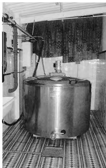
Lechería con terminaciones correctas
