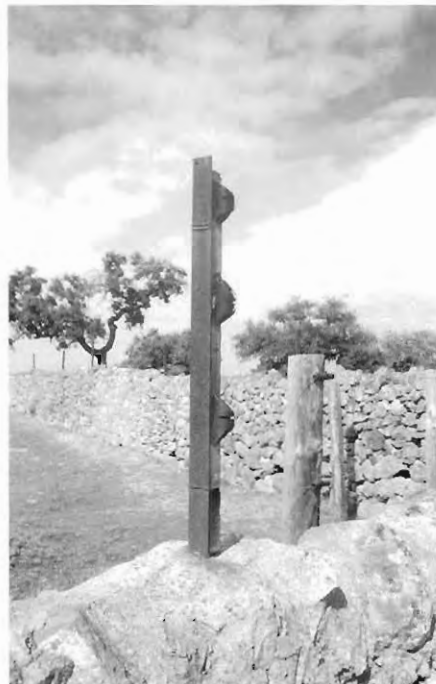
Detalle de un aislador.
