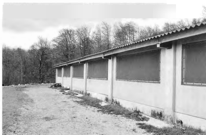
Área de reposo con terminación exterior realizada con pintura plástica. En las ventanas se ha colocado rejillas de plástico para controlar la velocidad del aire
