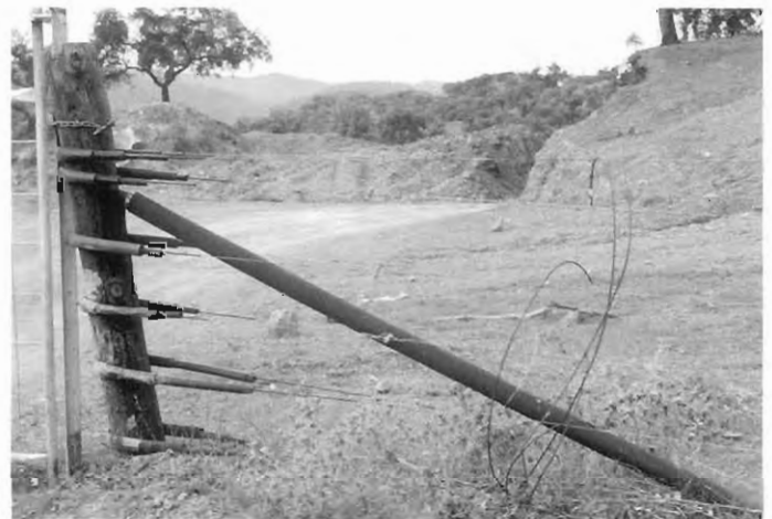
Detalle de un poste de amarré en una cerca de tensión con hilos electrificados. El aislamiento de los hilos se realiza por medio de tubos de plástico
