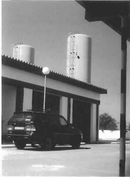
Vista de la estación de bombeo donde fueron instalados los equipos que componían el centro de control. En el extremo de uno de los calderines se instaló la antena omnidireccional para las comunicaciones vía radio.
