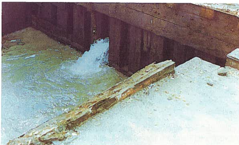
Vía de agua
