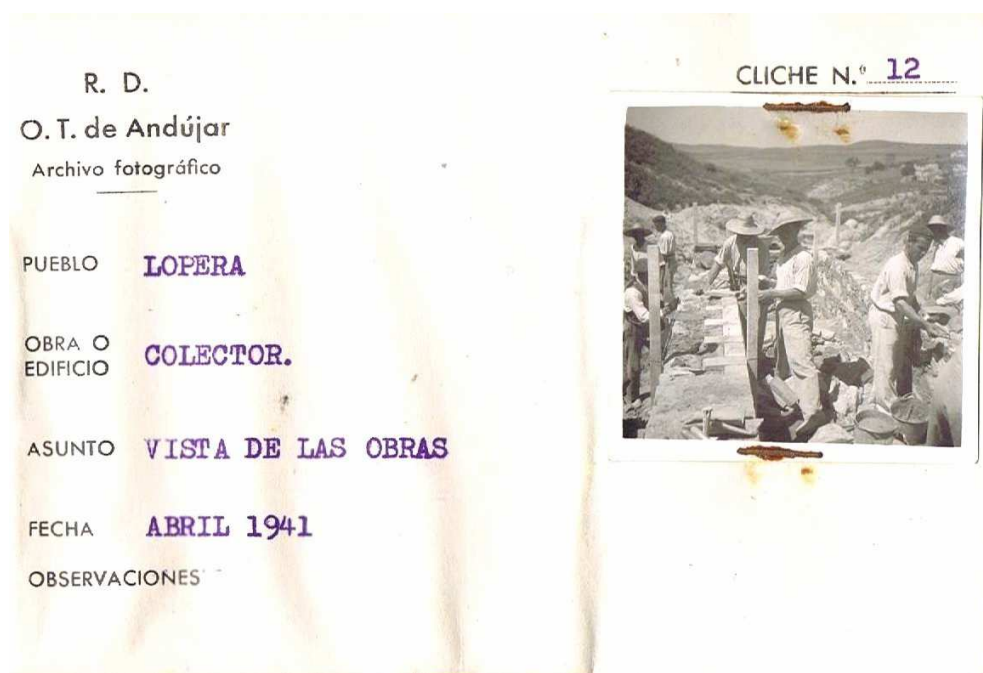
[Foto 1. Vista de la obra del colector. Lopera. Ficha de obra. Cliché nº 12. 1941, abril. AHPJ]
