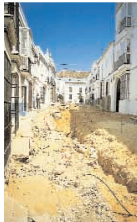
Sustitución de las Infraestructuras de saneamiento obsoletas. Calle Pablo Iglesias. Medina Sidonia (Cádiz). 7/98.
