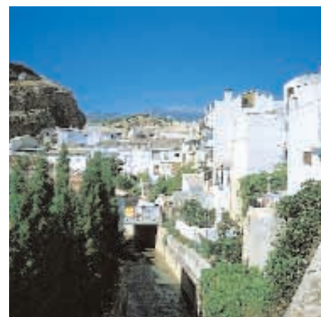
Topografía difícil, con un curso de agua que atraviesa el Centro. Cambil (Jaén).
