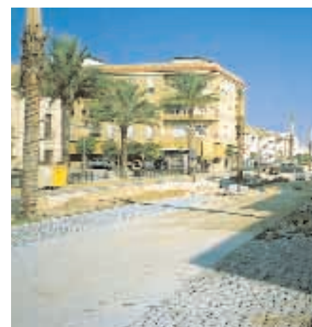
Remodelación de la antigua Travesía, como espacio libre longitudinal. La Carlota (Córdoba). 12/99
