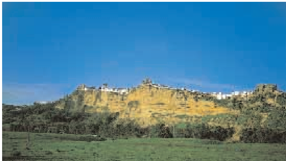
Falta de estabilidad de los Terrenos: Ladera de la Peña Nueva sobre el Río Guadalete. Arcos de la Frontera (Cádiz). 2/97
