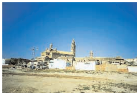
Indefinición en zonas de borde y traseras edificaciones. Zona cercana al cauce del Río Genil: Palma del Río (Córdoba). 8/97.
