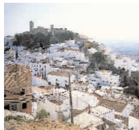
Postes, cables y edificaciones en construcción, que deterioran el Paisaje Urbano. Casares (Málaga). 8/98.
