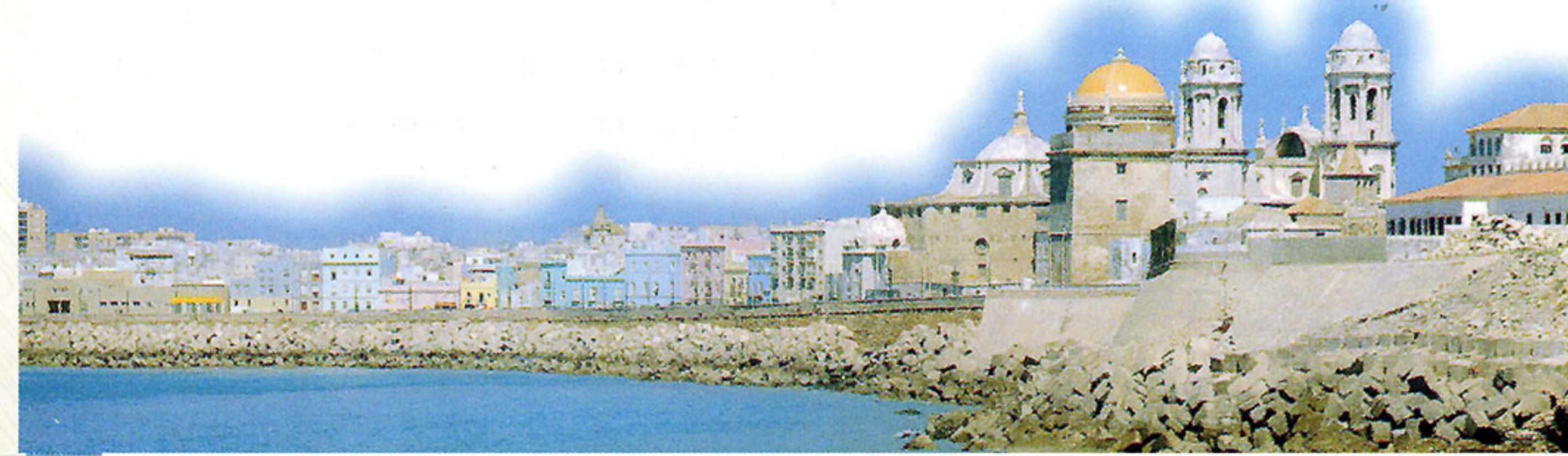
Cádiz. Rehabilitación de fachadas en Campo del Sur.
