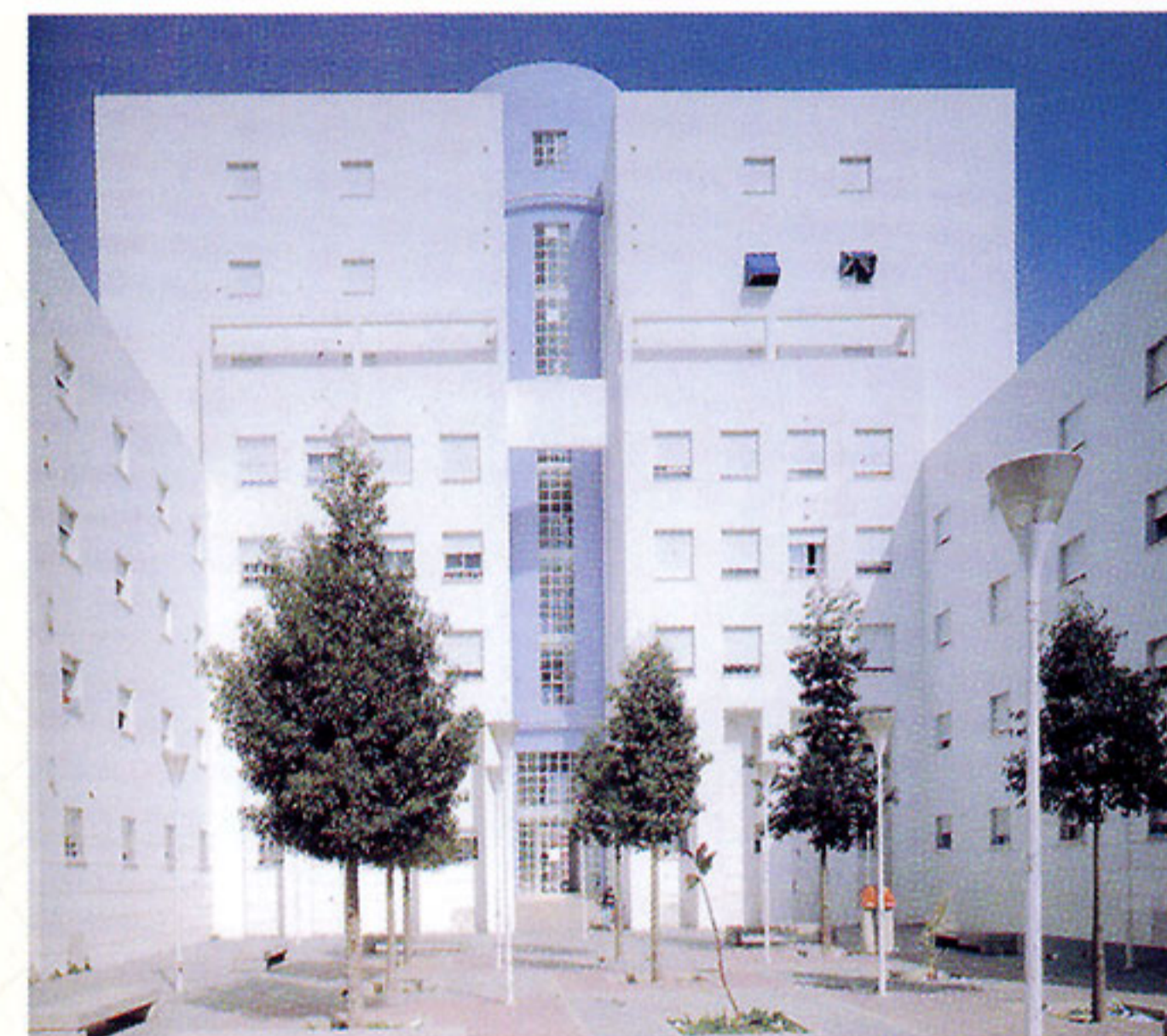
Huelva. 64 viviendas en Los Rosales.
