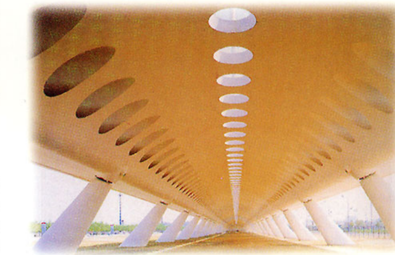
Sevilla. Viaducto del puente del Alamillo.
