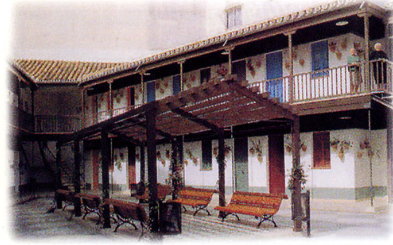
Málaga. Rehabilitación del Corralón de Santa Sofía.
