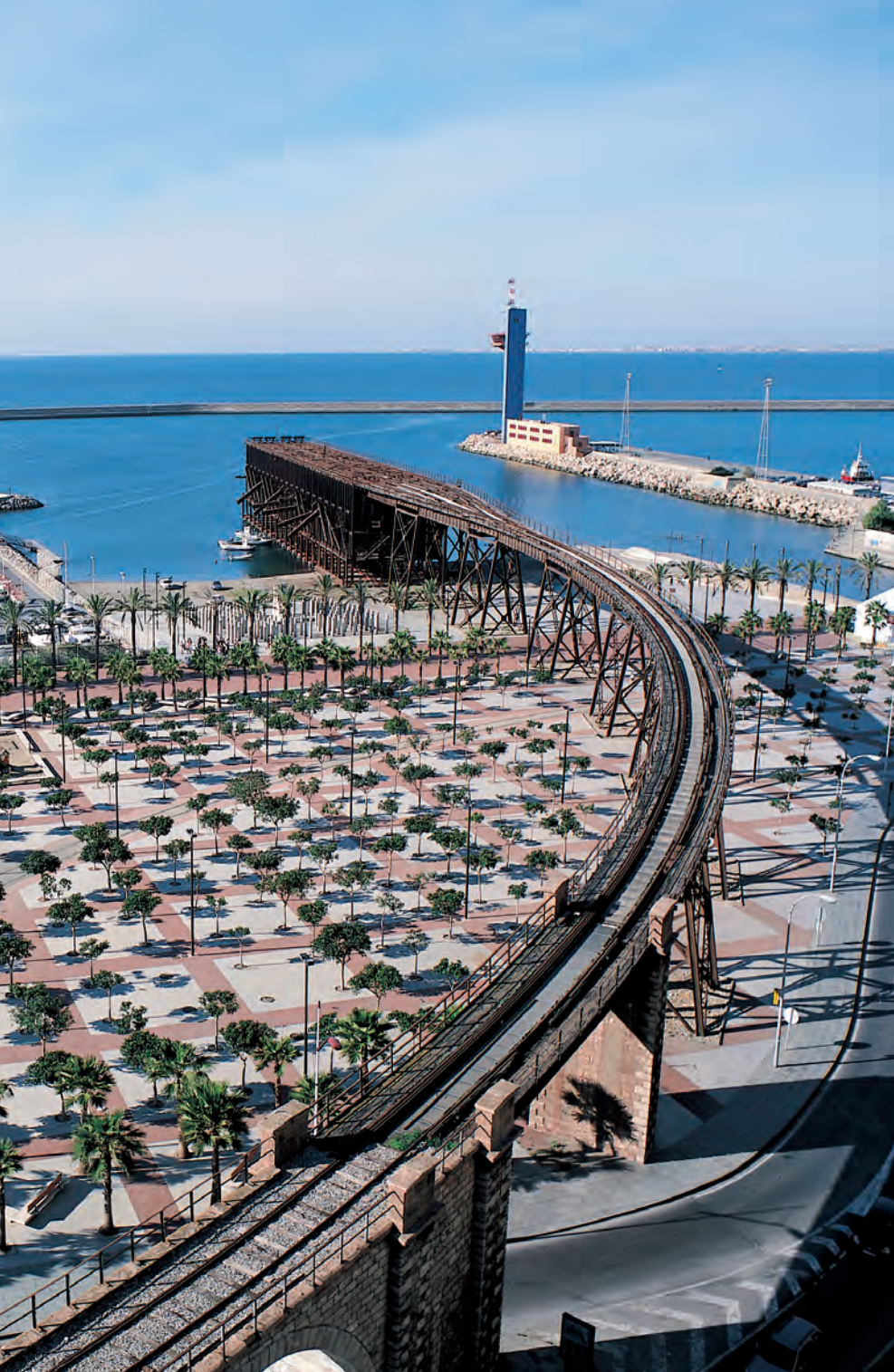
CARGADERO DE MINERAL EL ALQUIFE, Almería
