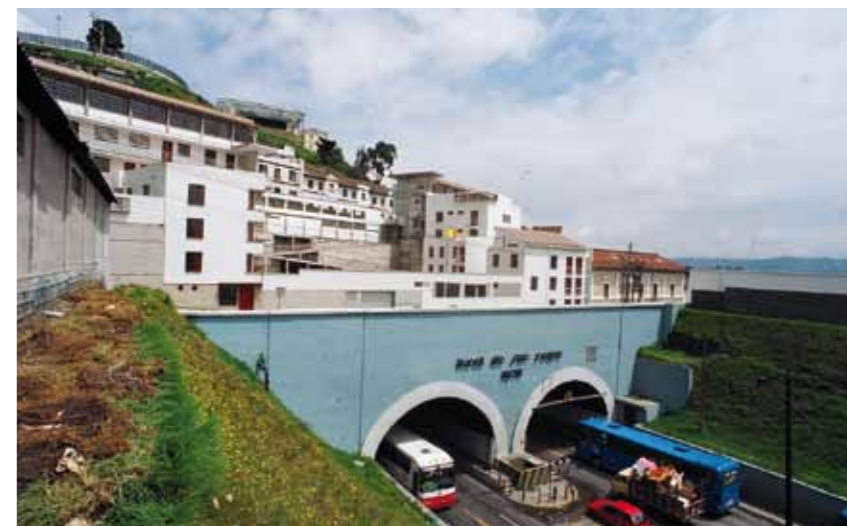
Vista del Túnel de San Roque bajo El Penalillo
