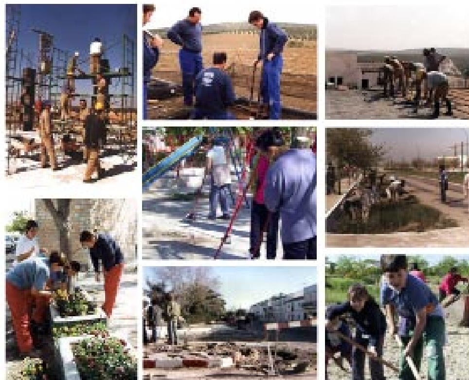
Imágenes de las viviendas y de algunos propietarios en el proceso de autoconstrucción Imágenes extraídas de la experiencia vivienda de autoconstrucción en Marinaleda
