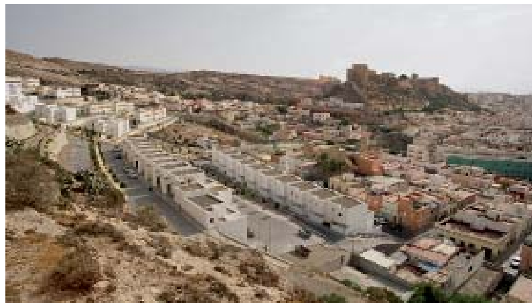
Fotografías del barrio de La Chanca, Almería, antes y después de la intervención.
