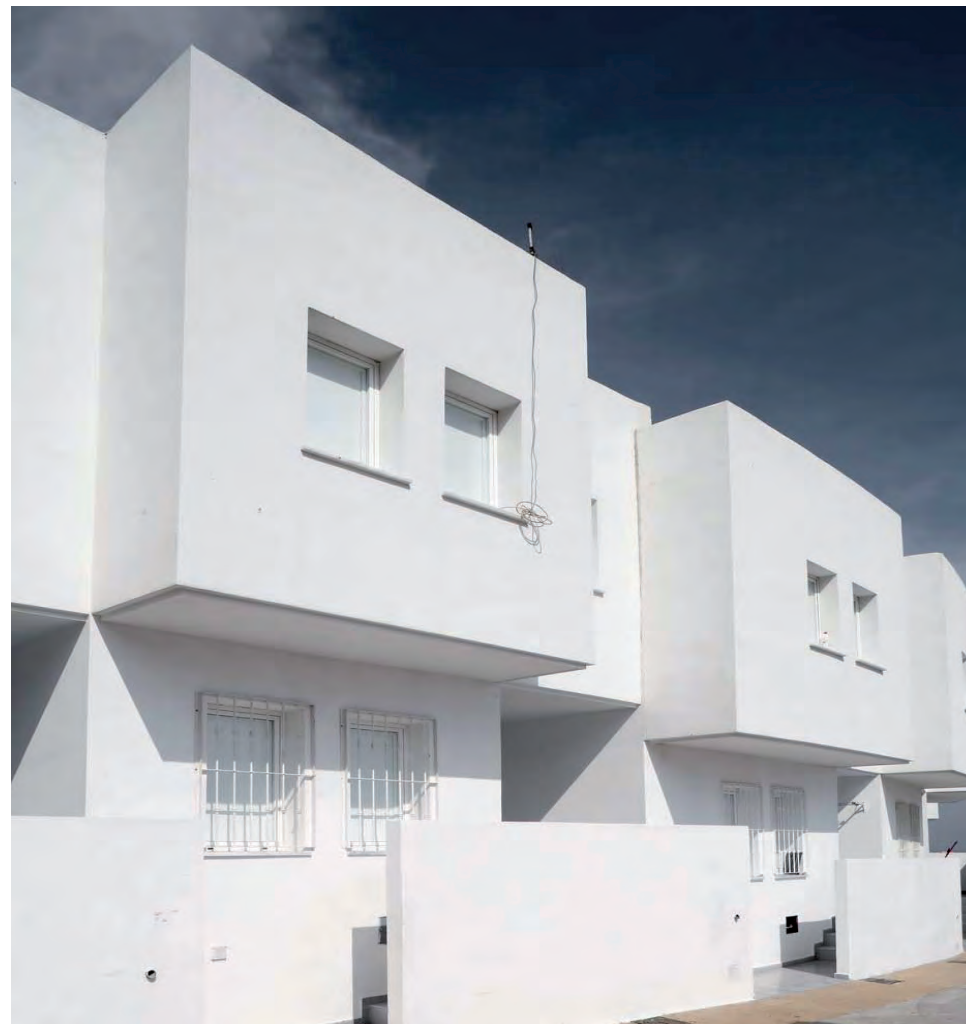
Actuación en Cuevas de las Palomas Actuación en Cerrillo del Hambre pertenecientes al Programa de Rehabilitación del Barrio de la Chanca (Almería)
