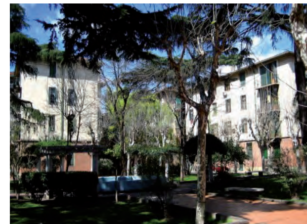
Planta del Conjunto Los Andes, arq. Fermín Berterebide El conjunto desde la calle Interior de la manzana
