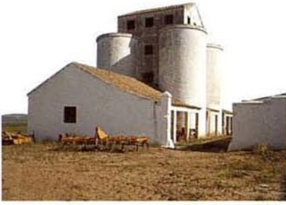
Cortijo Algamarrilla. Almodóvar del Río (Córdoba). Silos
