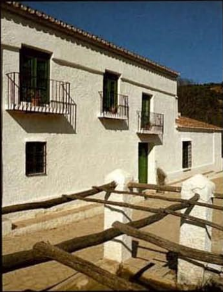
Lagar Torrijos. Málaga . Acogida de visitantes y guardería rural del Parque Natural de los Montes de Málaga
