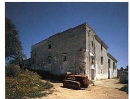
Casa Molino Bachiller Viejo. Arcos de la Frontera
