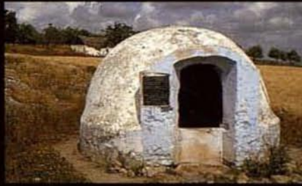
Molino del Rey. Íllora (Granada). Acueducto
