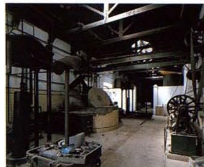
El Salcedo. Baños de la Encina (Jaén). Almazara hidráulica
