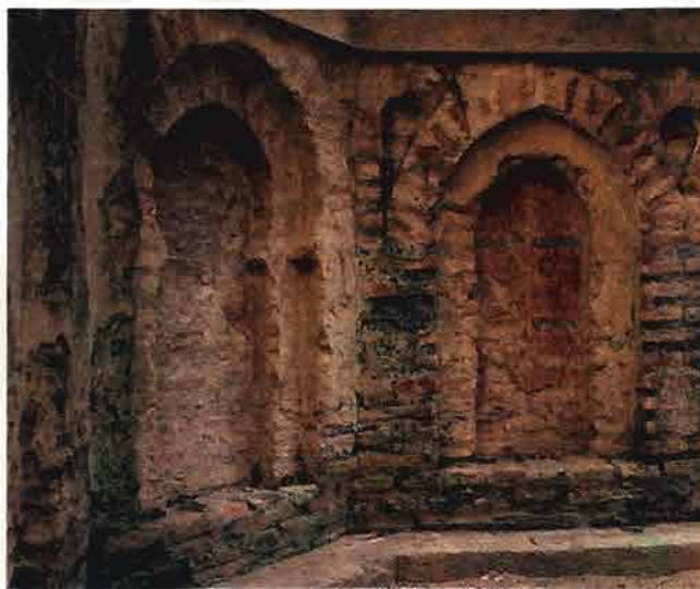
Fig. 14. Estucados y pinturas en la obra almohade.
