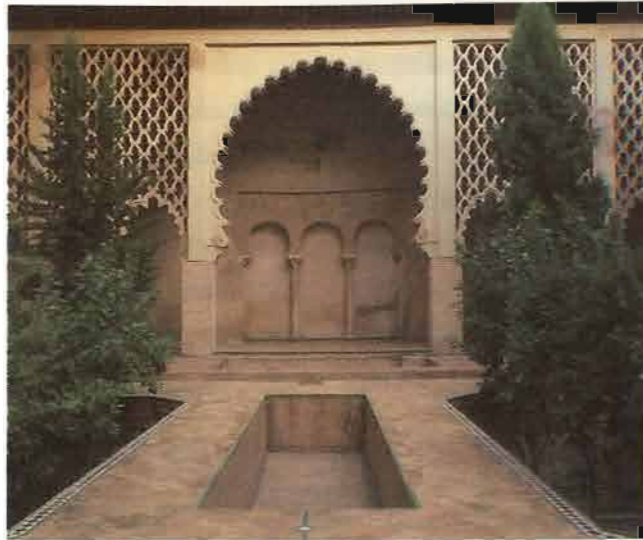
Fig. 16. La anastylosis de la fachada al sur con el arco central reconstituido. Al fondo la arque- ría que daría paso a la sala hoy oculta.
