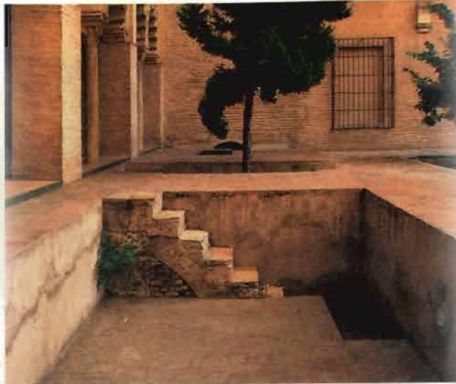
Fig. 11. Alberca en el testero norte, se observa el recrecido en la escalera y muros. Junto a ellos la cata que permitió descubrir dos peldaños más y la solería inferior.
