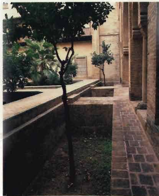
Fig. 12. Rampa en el testero sur. A la derecha puede observarse el basamento de una de las columnas.
