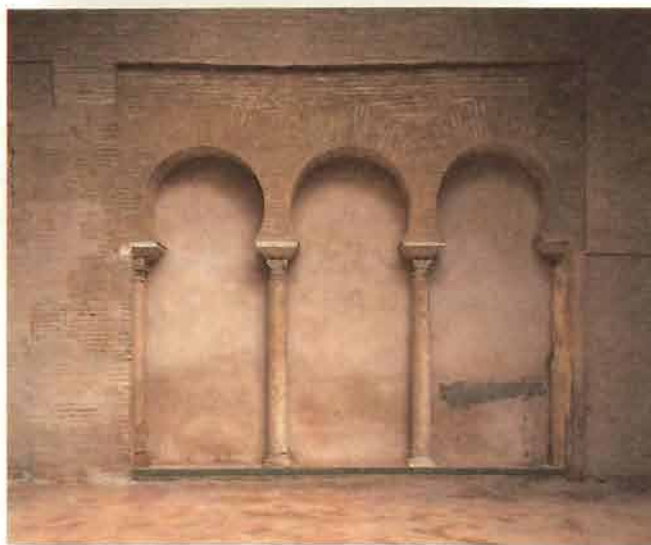
Fig. 9. Arquería en la fachada al sur.
