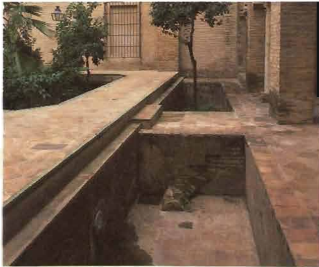
Fig. 17. Restos de la escalera en la alberca del costado sur y reconstitución de las diversas solerías.
