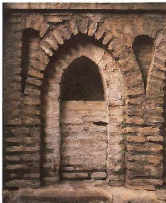
Fig. 6. Arquería en el trazado almohade con los orificios que dejan ver el muro anterior.
