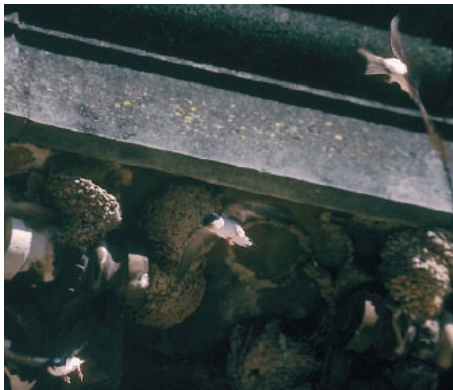
El avión común ( Delichum urbica ) es una especie frecuentemente ligada al espacio urbano, que construye sus nidos en paredes y aleros de edificios
