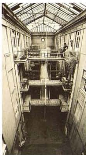
(Arriba) Edificio en calles Burgues y Antonio Machado, Montevideo.
