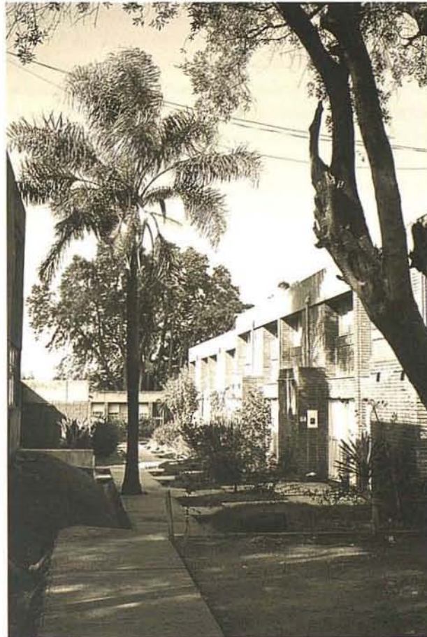
Forestación, detalle de revestimiento y caminería.
