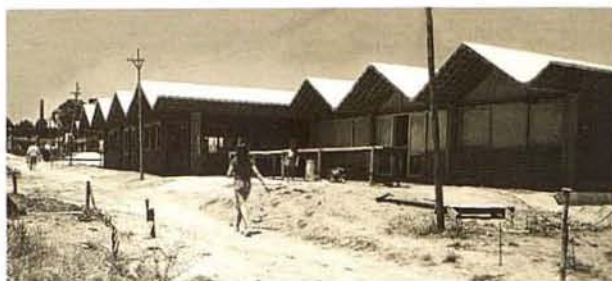
(Arriba) Techo plegado del salón comunal de zona 6 realizado con losetas de ladrillo.
