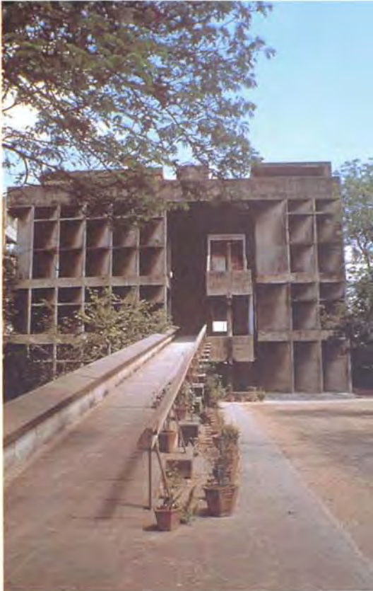
Vista de la fachada principal con la rampa
