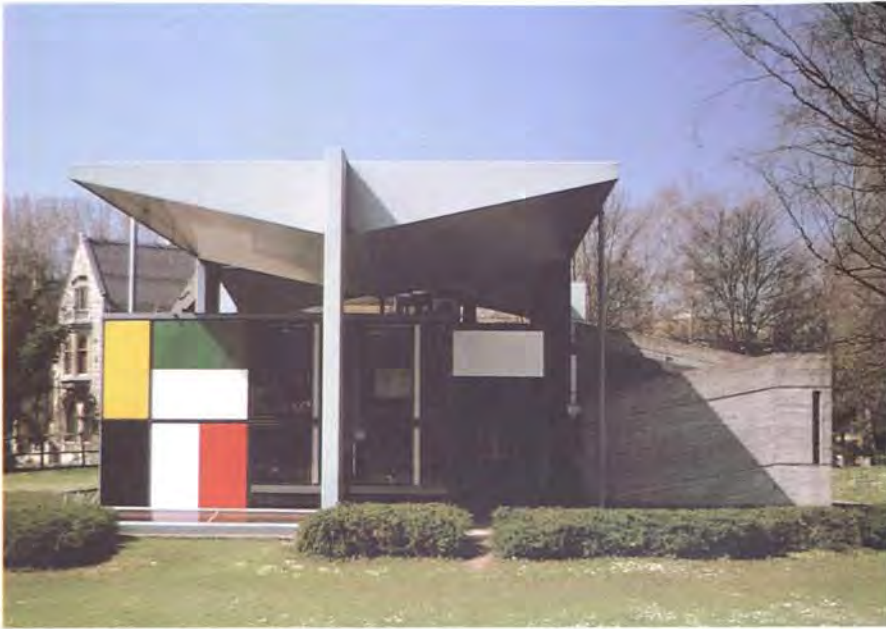
Aspecto del edificio hacia el sur
