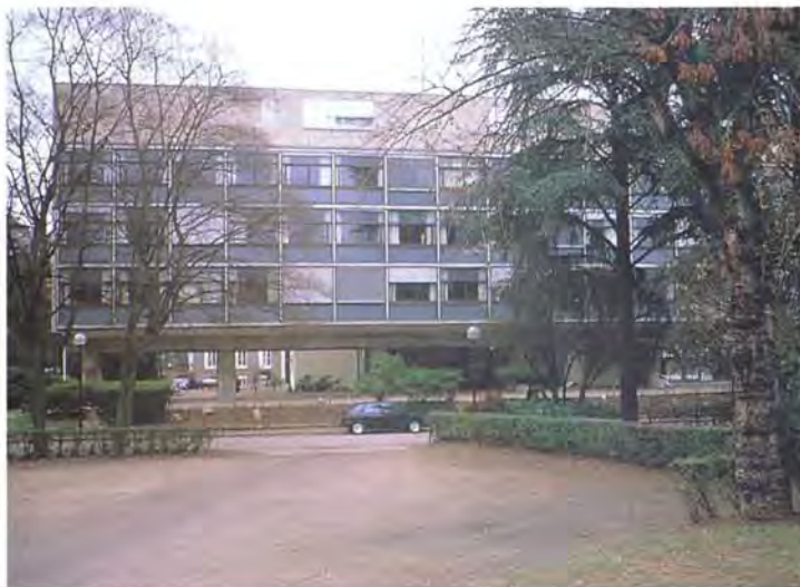
Vista de la fachada sur
