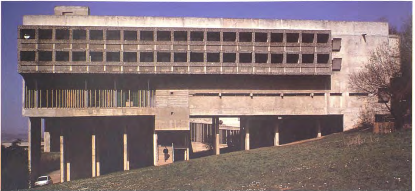
Vista de la fachada meridional
