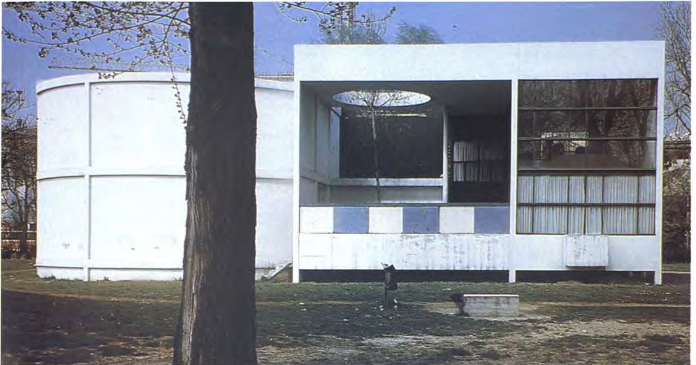
Reconstrucción del Pabellón del Esprit Nouveau, 1922
