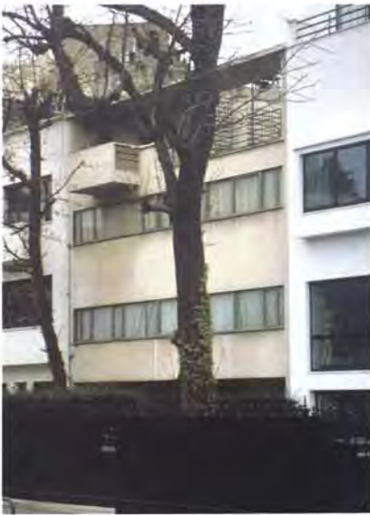
Casa Cook. Alzado. Estado actual
