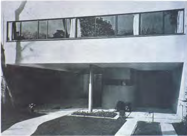
Acceso. Estado original
