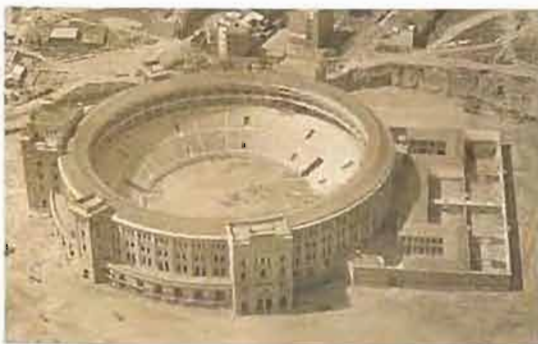
La plaza de toros de las Ventas en construcción, en una fotografía tomada hacia 1929. MUSEO MUNICIPAL DE MADRID
