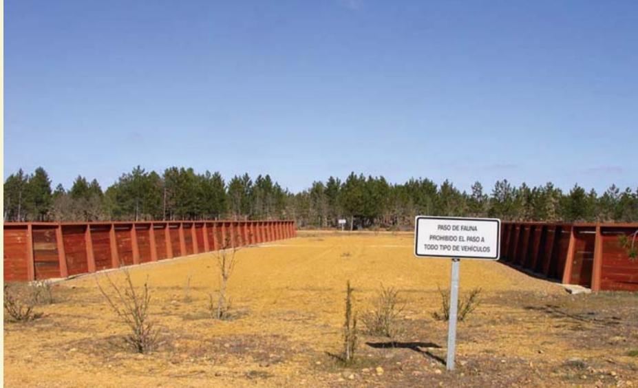
Los pasos superiores específicos para la fauna son estructuras muy efectivas. No obstante, tienen notables dificultades para el mantenimiento de las revegetaciones, y es fundamental evitar otros usos que pueden perturbar a la fauna, como el paso de vehículos. El apartamiento del paso, muy bien resuelto en este caso, es importante para evitar que el paso de animales se vea afectado por la visión de los vehículos que utilizan la vía. Autovía A67, León Burgos. Foto: Carme Rosell.
