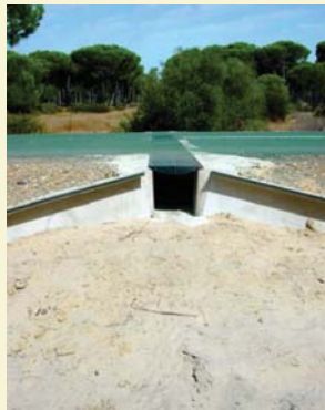
Detalles de la embocadura del paso de anfibios en la Laguna de la Mar
