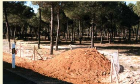
Rampa de escape para lince y vertebrados
