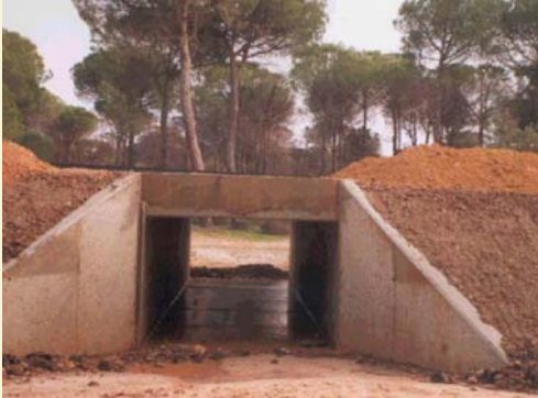
Marco 3x2 m. en construcción. PK. 9+245
