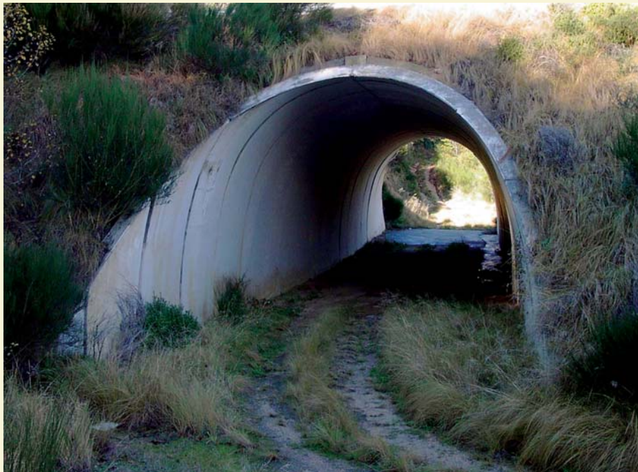
El paso de fauna es compatible con un uso muy esporádico de las estructuras por parte de vehículos, pero no es recomendable la adaptación de pasos que tengan una alta intensidad de tránsito. Carretera C65, Eix Transversal de Catalunya. Foto: Carme Rosell.
