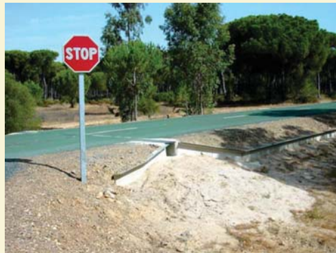
Detalles de la embocadura del paso de anfibios en la Laguna de la Mar
