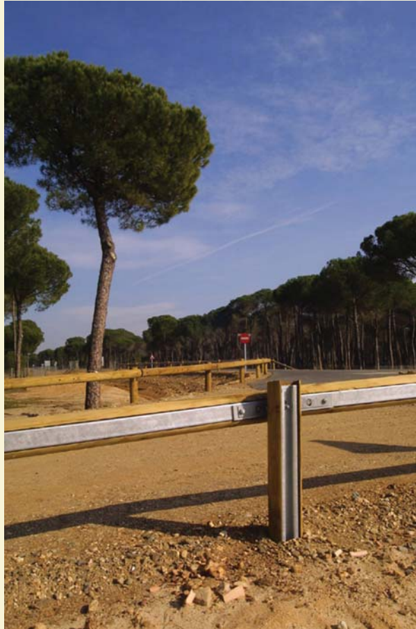
Barrera de seguridad forrada de madera
