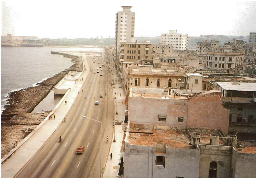
AVENIDA DEL MALECON Y LOS BAÑOS EXCAVADOS EN LAS ROCAS. LA HABANA, MALECON Proyecto Malecon Cuba+España, Sevilla.
