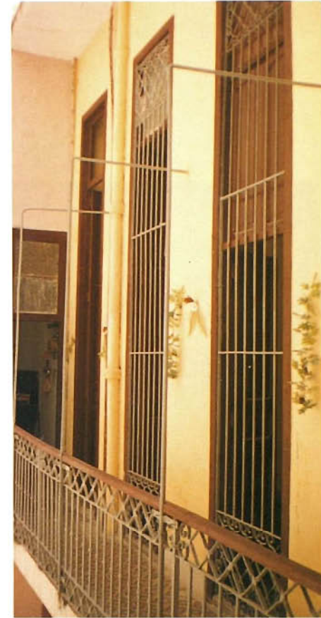
INTERIOR DE EDIFICIO DESPUES DE REHABILITARSE EN EL MALECON. MALECON Nº 27 Proyecto Malecón Cuba+España. Sevilla
