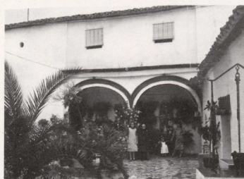
Estado anterior a la obra.
