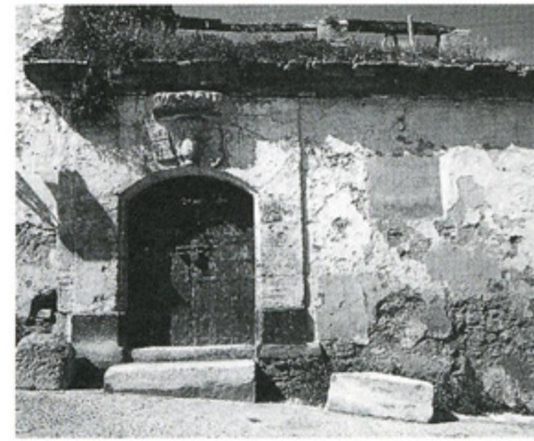
Estado anterior a la obra.
