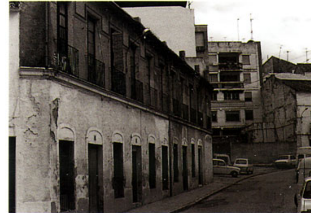
Estado de la fachada antes de la obra.
