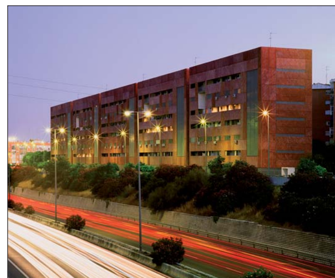
vista general del conjunto
