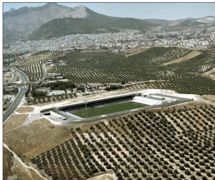
vista general del conjunto en su entorno
