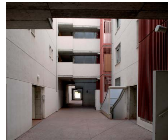
vista de patio-galería de servicios
