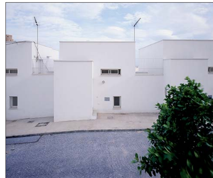
vistas de fachada oeste
