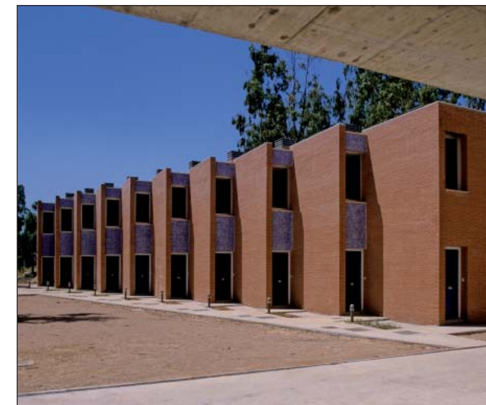
vista de viviendas adosadas desde el porche del bloque
