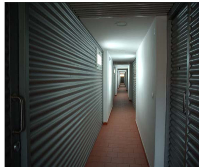
vista de pasillo distribuidor de viviendas
