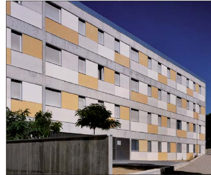
imagen fachada principal
