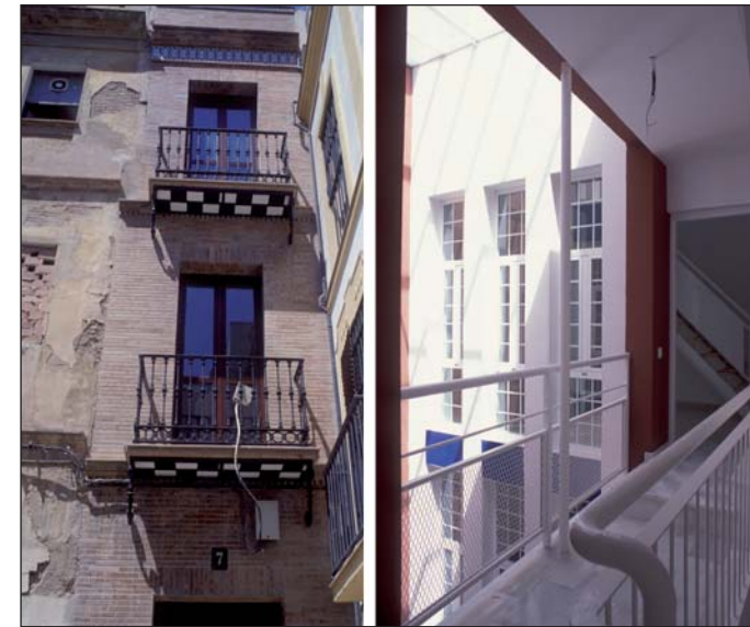
estado reformado vista de fachada y patio
