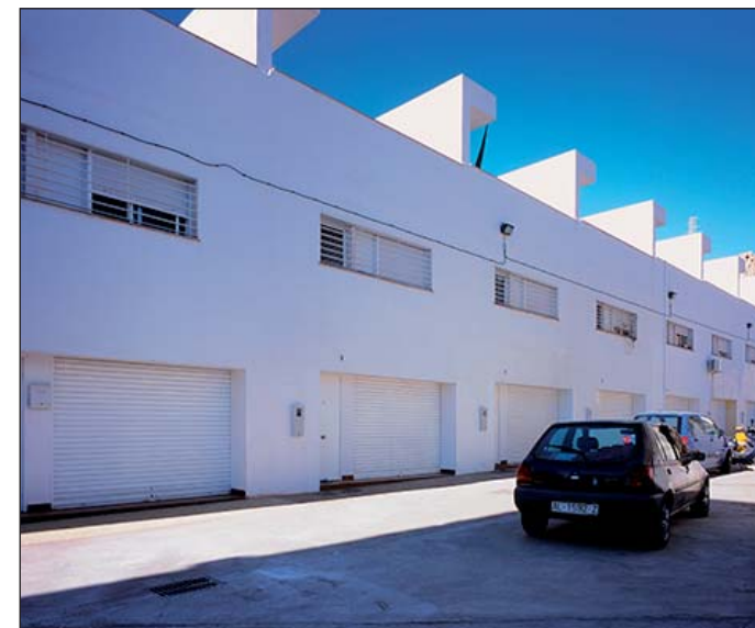
vistas de fachada oeste
