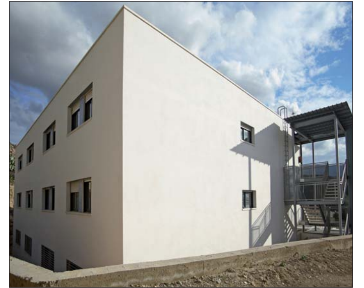
imagen fachada trasera
