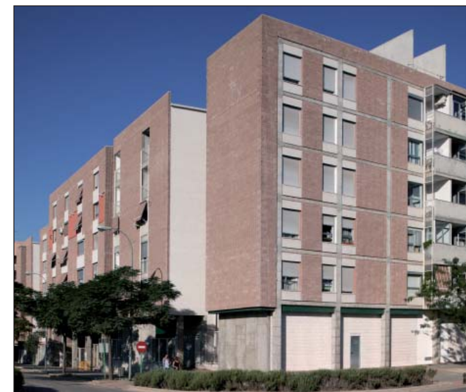
vista de fachada sur
