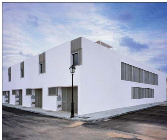
vista general del conjunto
