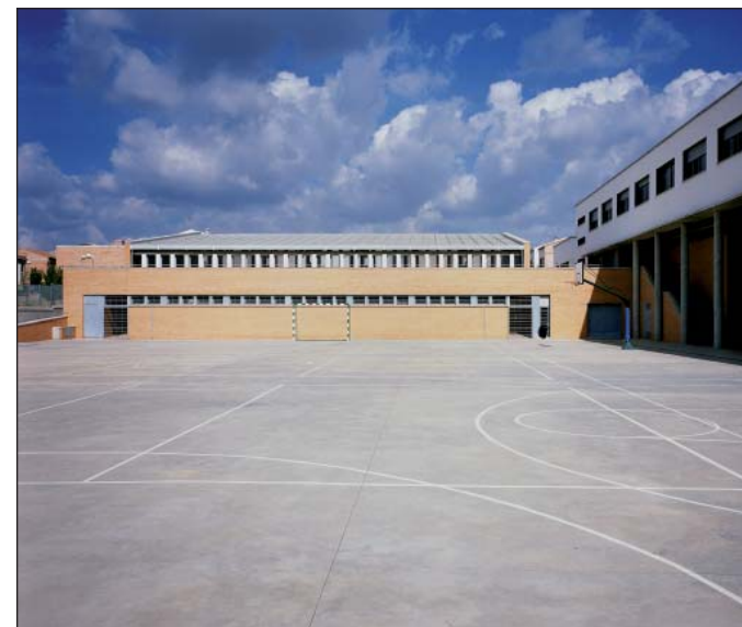
vista desde pista deportiva/zona de recreo
