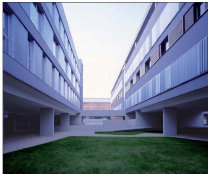
vista de patio
