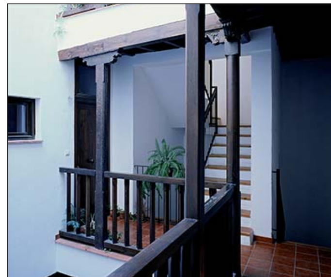
vista de galería de acceso a viviendas
