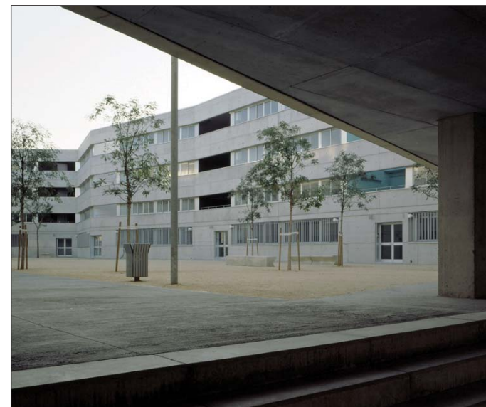
vista del patio desde porche de acceso
