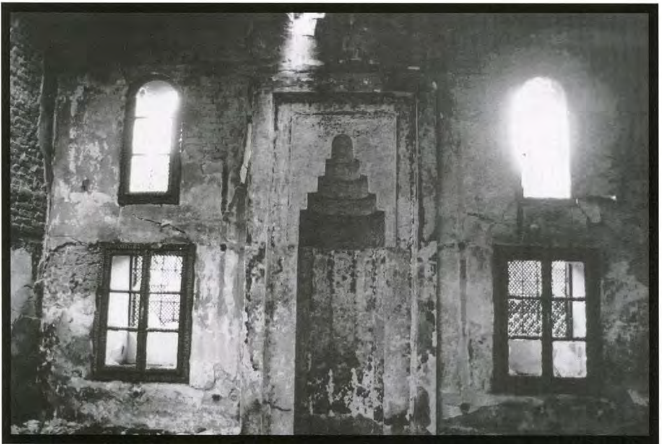
Mesdjid de Hadzi-Osman o Mesdjid Tabacki arquitecto desconocido - 1592 - calle Gornji Tabaci - detalle de ventana
