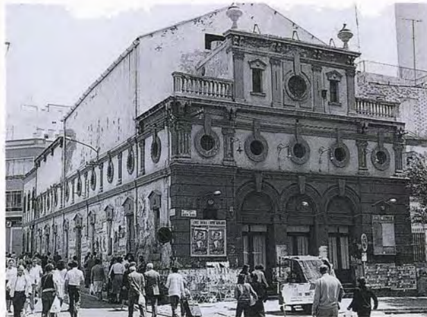
Estado del edificio anterior a la obra. Foto: Andrés Lora
