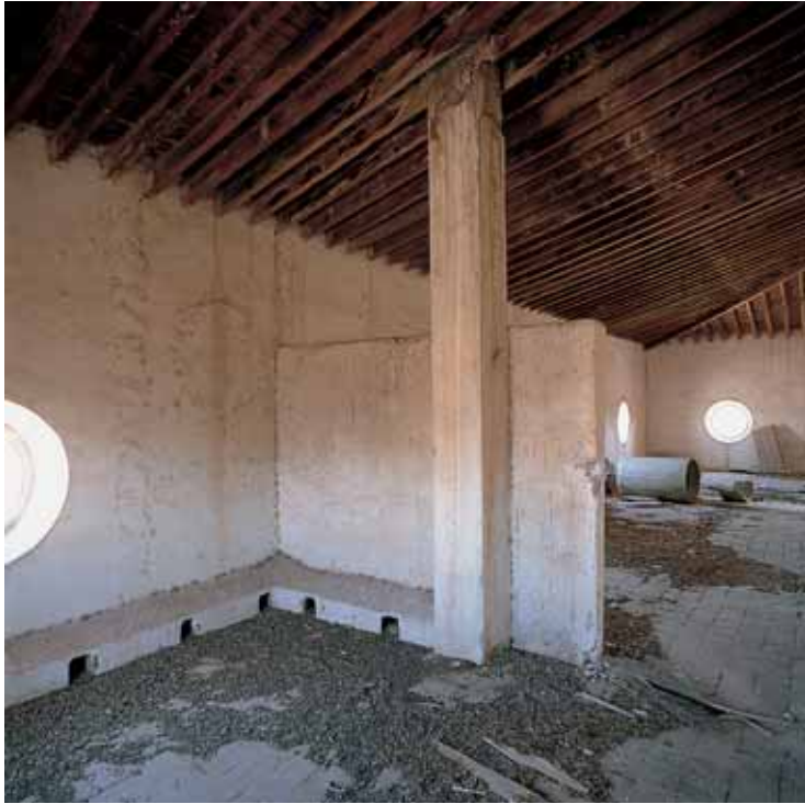
A la izquierda, los trojes y secaderos, en planta segunda. A la derecha, distribuidor situado bajo el lucernario de planta primera, residencia de los propietarios.
