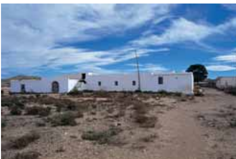
A la derecha, la explanada de la era y el acceso al cortijo. Abajo, fachada trasera, donde se observa la escalera exterior del pajar, y núcleo con el cuerpo cilíndrico de la molina.
