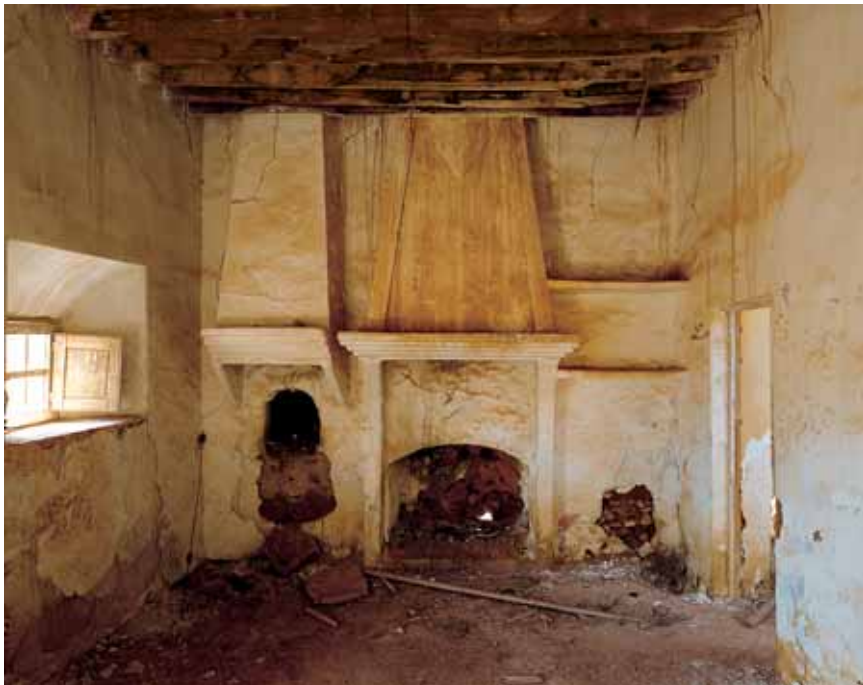
Arriba a la izquierda, cortijo de aparceros en la Hacienda el Romeral; a la derecha, horno de pan del Cortijo Perianos, Adra; sobre estas líneas, Cortijo el Fraile, Níjar
