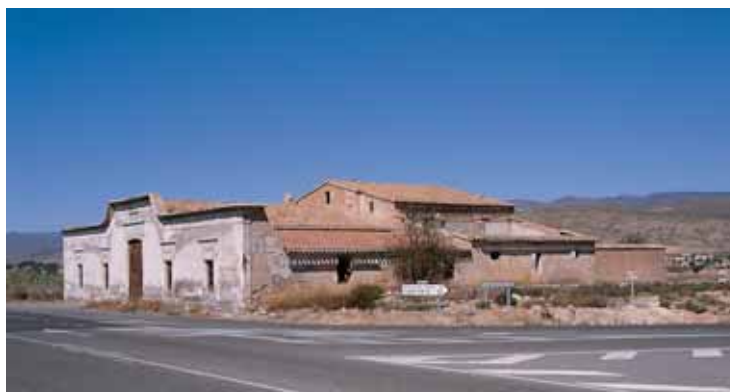
Fachada y conjunto de la venta y almazara; el sector delantero corresponde a la vivienda y cuadras, y el volumen central, más elevado, a la fábrica de aceite.
