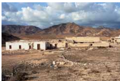
Fachada del cortijo hacia poniente, con el sector de la vivienda principal. A la derecha, zona trasera del conjunto, con las eras circundadas por muretes de mampuestos.
