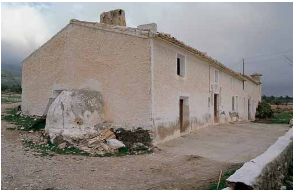
Fachada con los accesos a las viviendas y el horno adosado al muro en primer plano.
