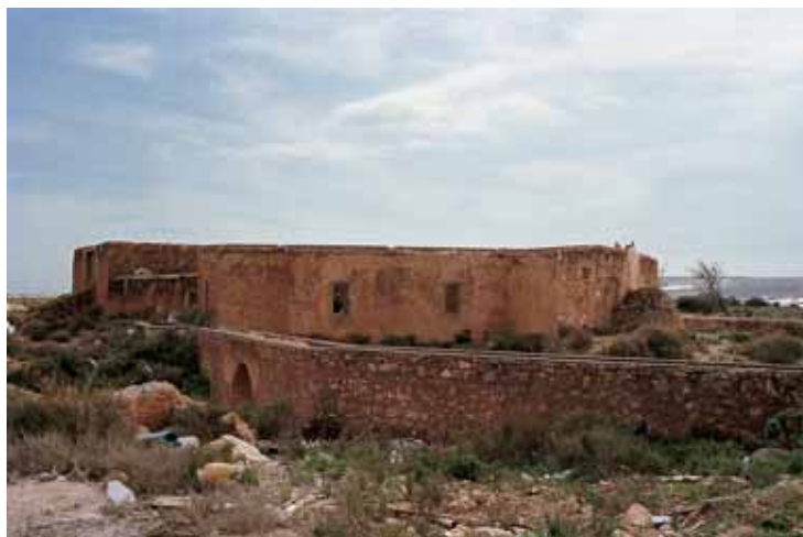
Trazado de la acequia, que salva los desniveles sobre un arco, y que abastecía a la almazara del cortijo.
