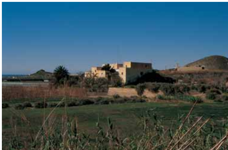
Vista de conjunto del cortijo desde el norte. A la derecha, situación del edificio entre invernaderos.
