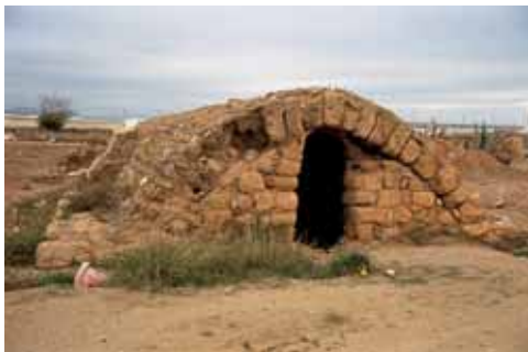
Aljibe situado en las inmediaciones del cortijo, cubierto por bóveda de cañón hecha con sillarejos.
