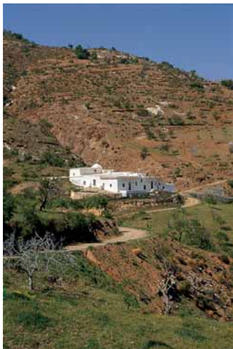
El cortijo, ubicado en una ladera con almendros. Por encima de la edificación se encuentra la era.
