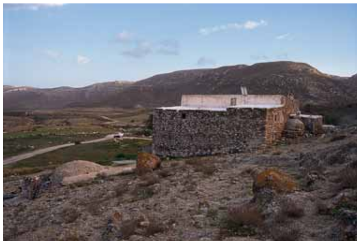
Bloque trasero donde se sitúan las cuadras. A la izquierda aparece una cochineras bajo cúpula.
