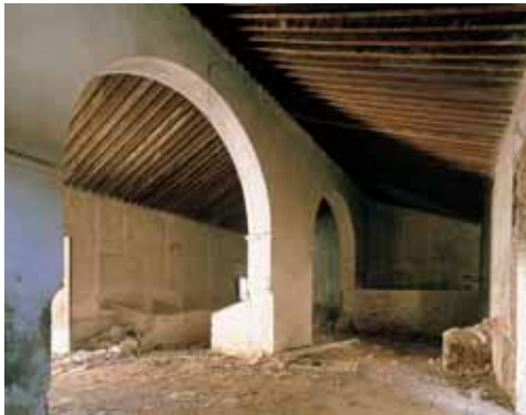
Arriba, fachadas de la capilla, junto al arco de entrada, y del pabellón principal hacia el patio. Abajo, interior de la nave de la antigua almazara, donde se observan los trojes para depositar la aceituna, a la izquierda.
