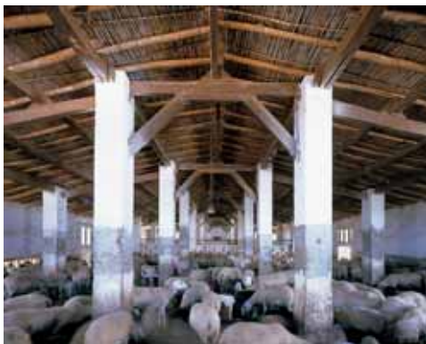
Nave de ganado, con estructura de madera sobre pilares cuadrados, del Cortijo las Chiqueras.
