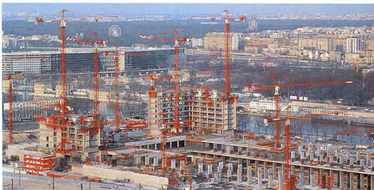
VISTA GENERAL DE LA OBRA.
