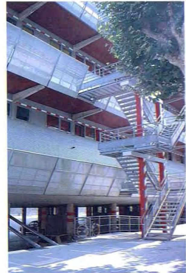
ESCALERAS DE ACCESO AL EDIFICIO DESDE LA CALLE.
