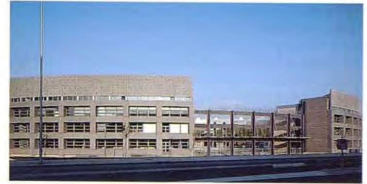
VISTA DE LA ENTRADA DEL LICEO.
