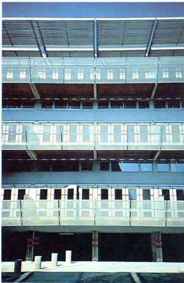
VISTA DE LAS FACHADAS NORTE Y SUR.
