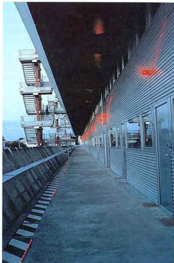
GALERIAS DE DISTRIBUCION A LAS VIVIENDAS.
