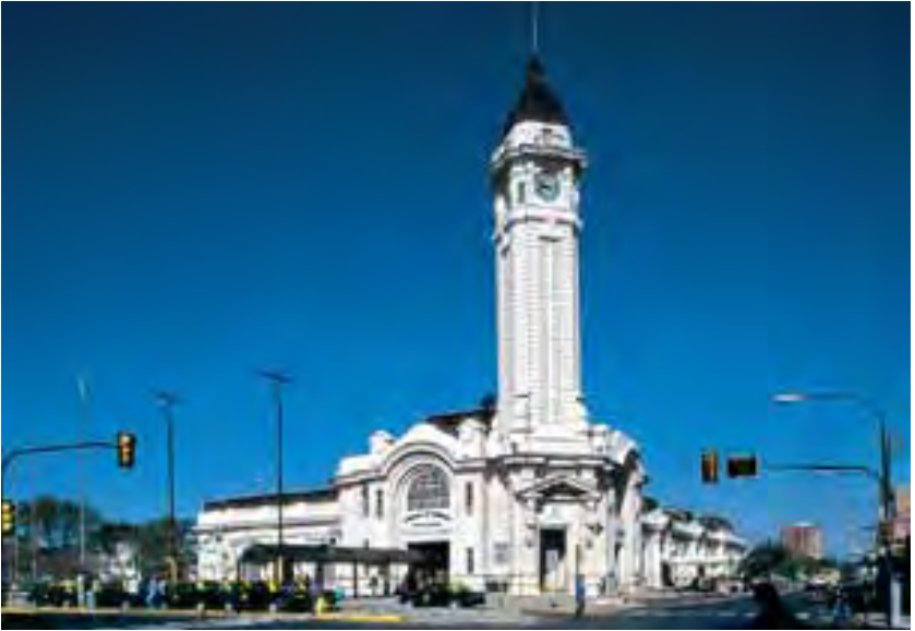
Torre terminal de ómnibus
