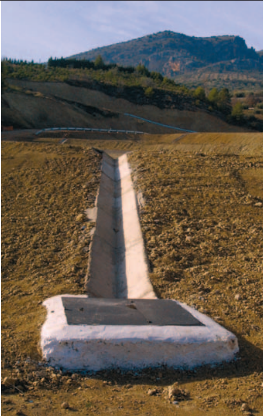
Embovedado arroyo Fuente Nueva, Quesada (Jaén).
