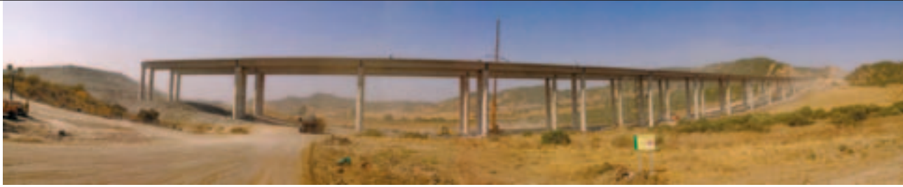
Construcción del viaducto río Álamo. Tramo IV, autovía A-381 Jerez-Los Barrios (Cádiz).
