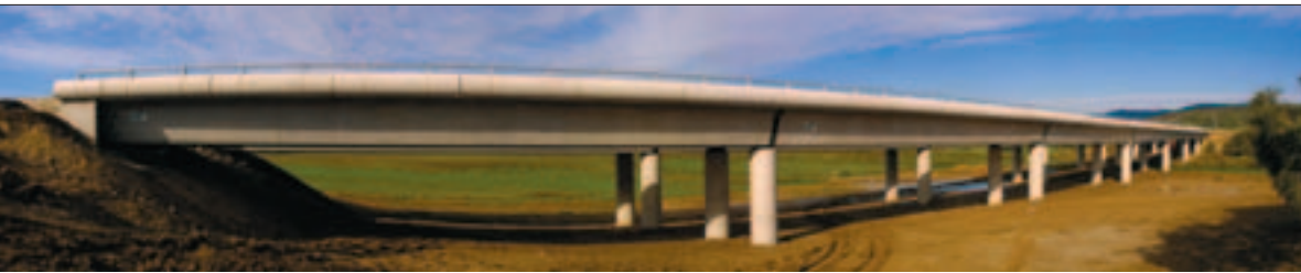
Viaducto, autovía A-381 Jerez-Los Barrios (Cádiz).
