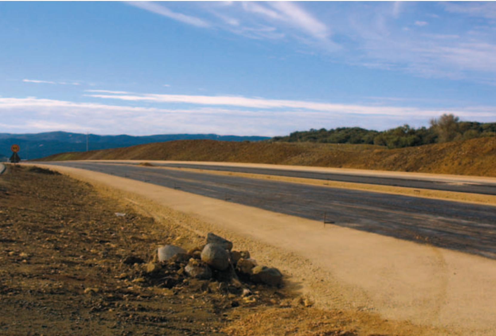
Construcción autovía A-381 Jerez-Los Barrios (Cádiz).
