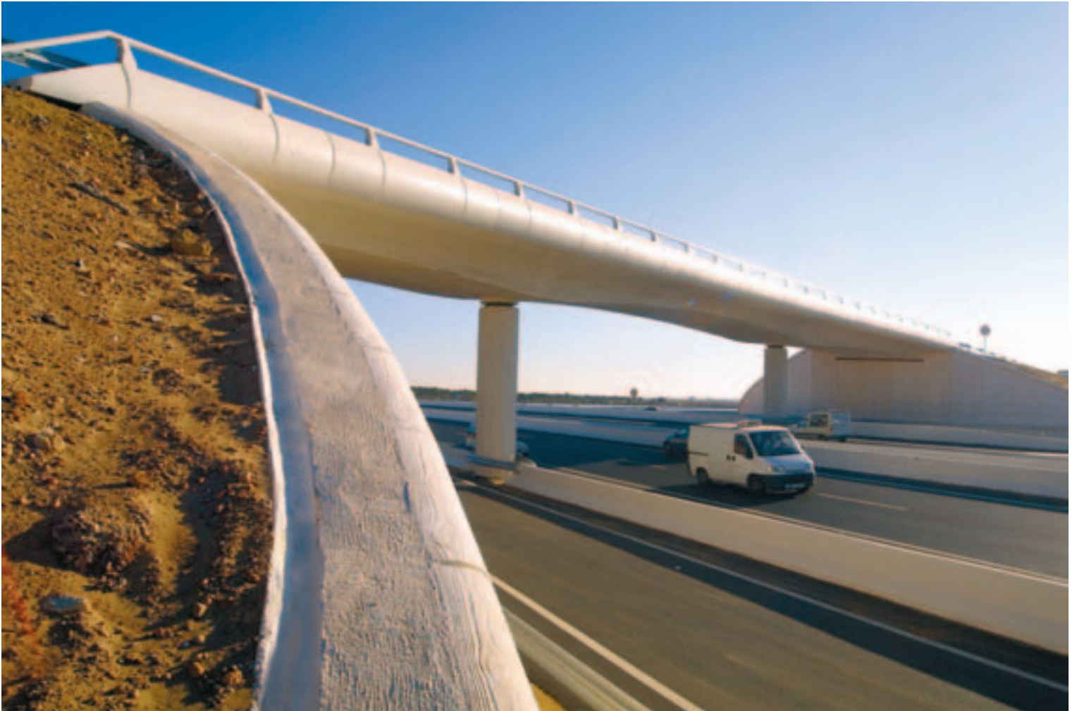
Paso superior, nuevo acceso a Punta Umbría (Huelva).
