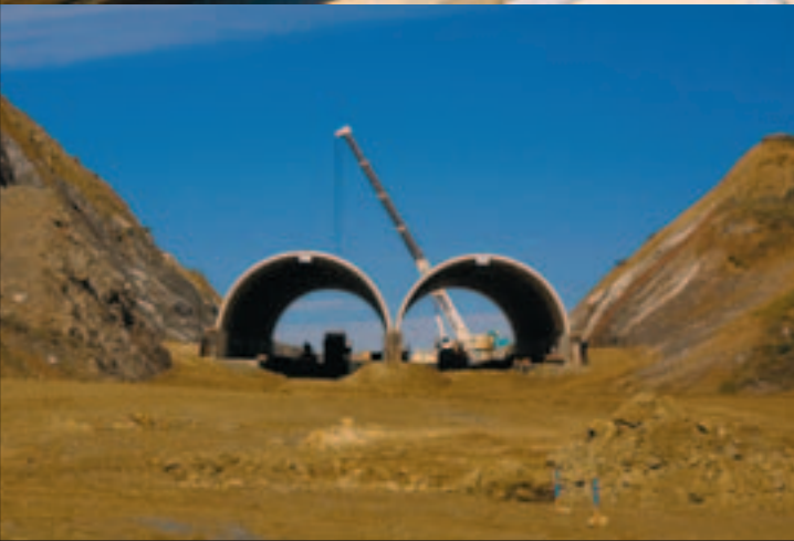
Construcción de falso tunel. Autovía A-381 Jerez-Los Barrios (Cádiz).
