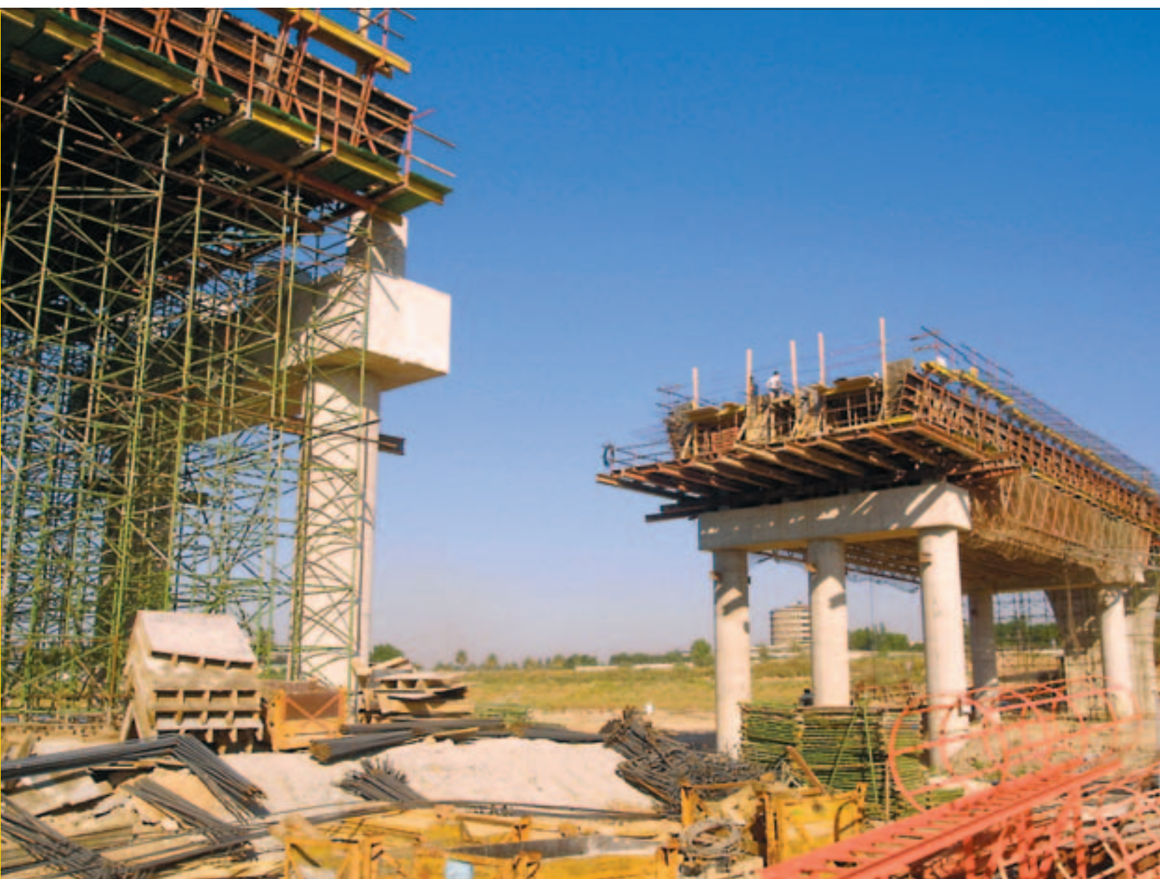
Construcción del Puente de Andalucía. Ronda Poniente de Córdoba.
