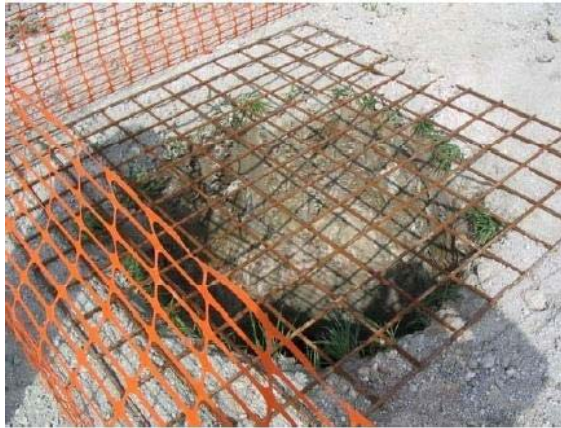
Modelo de protección a instalar cuando no se trabaja en el hoyo. Ha de tener condiciones de resistencia que impida la caída de una persona
