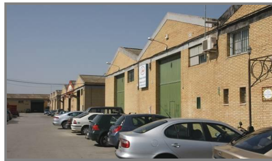
Polígono Industrial Majarabique
