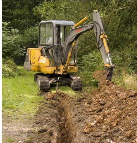
Imagen 34. Excavación de zanjas
