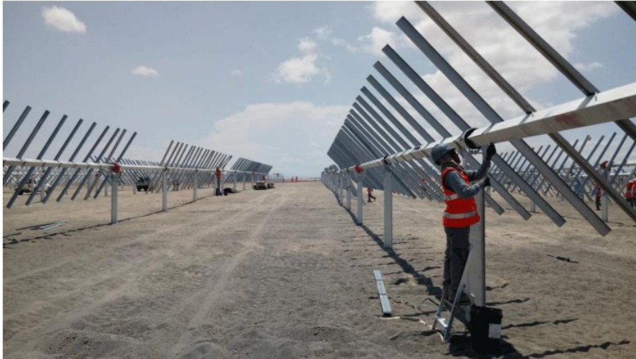
Imagen 35. Montaje de estructura seguidor con perfiles hincados directamente en el terreno
