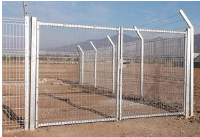
Imagen 31. Detalle de portón de dos hojas batientes tipo Acmafor
