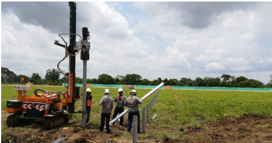
Imagen 33. Hincado de perfiles con maquinaria especializada
