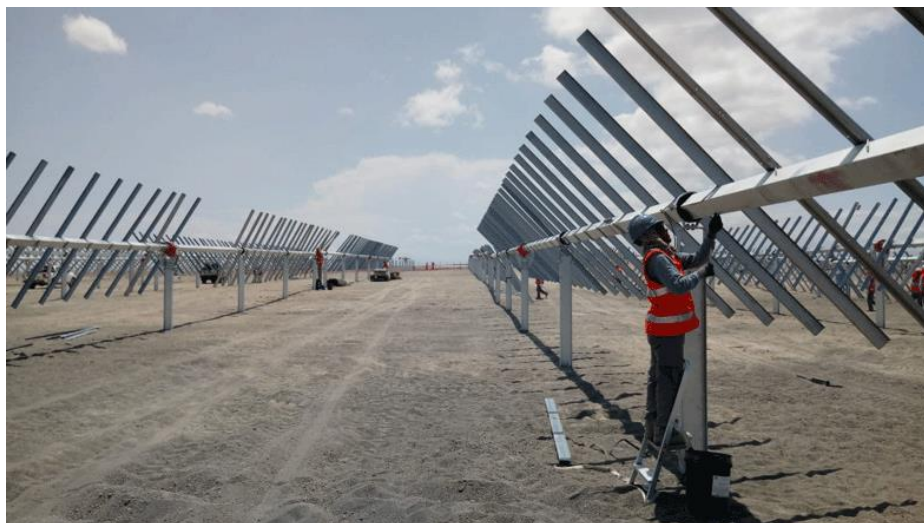
Imagen 34. Montaje de estructura seguidor con perfiles hincados directamente en el terreno
