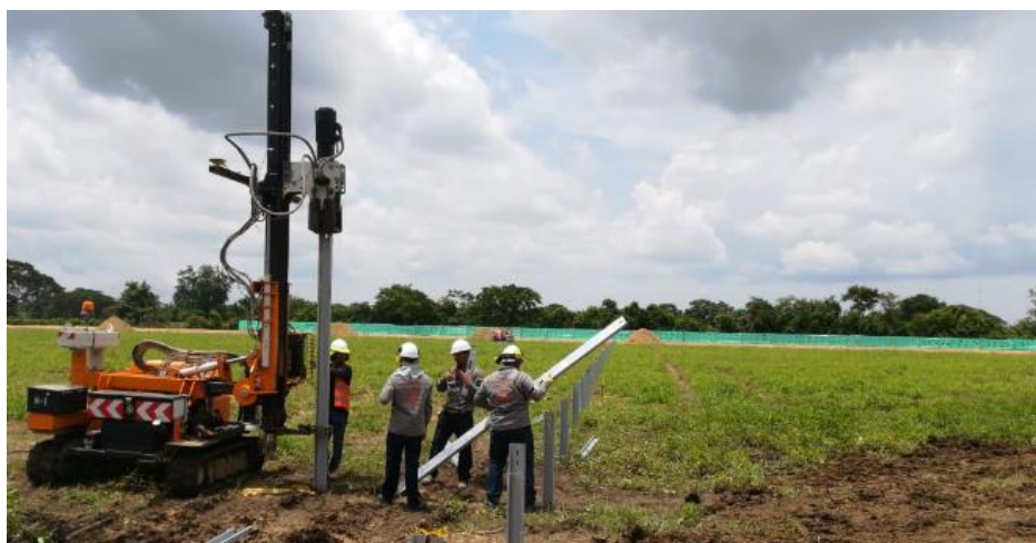
Imagen 32. Hincado de perfiles con maquinaria especializada
