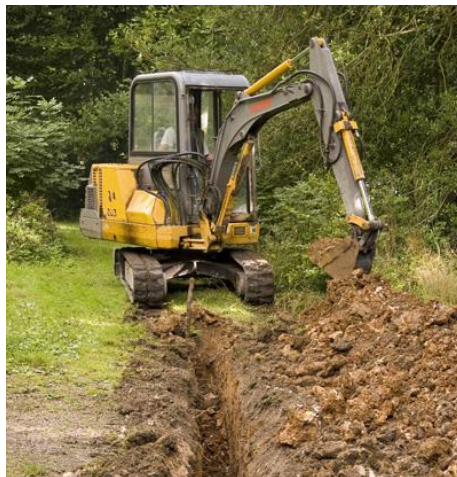
Imagen 33. Excavación de zanjas
