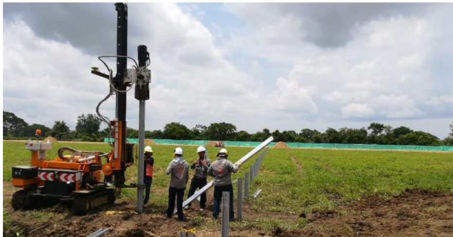
Imagen 23. Hincado de perfiles con maquinaria especializada
