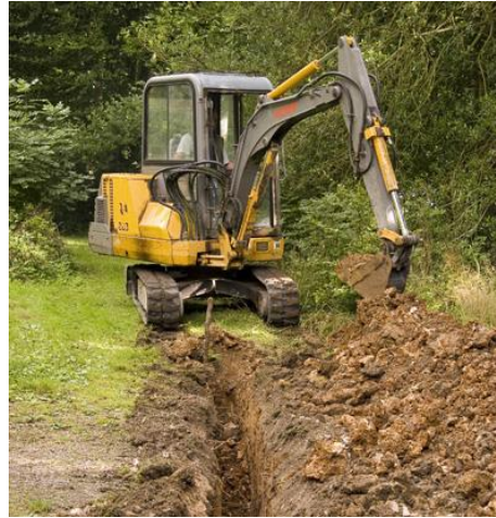
Imagen 24. Excavación de zanjas
