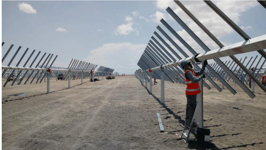
Imagen 25. Montaje de estructura seguidor con perfiles hincados directamente en el terreno
