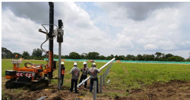
Figura 3.2.9.a. Hincado de perfiles con maquinaria especializada. Fuente: Modificados de los Proyectos de Ejecución de las Plantas Fotovoltaicas Venta Angulo, Los Llanos y Las Canteras. TT.MM. Baza y Caniles (Granada).
