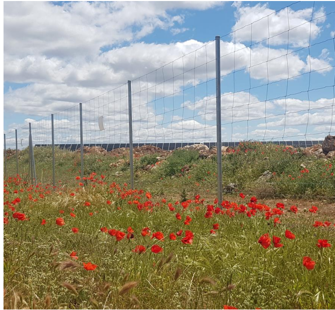
Figura 3.2.7.b. Vallado cinegético para cierre perimetral. Fuente: Modificados de los Proyectos de Ejecución de las Plantas Fotovoltaicas Venta Angulo, Los Llanos y Las Canteras. TT.MM. Baza y Caniles (Granada).
