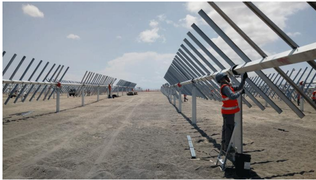
Figura 3.2.11.a. Montaje de estructura seguidor con perfiles hincados directamente en el terreno. Fuente: Modificados de los Proyectos de Ejecución de las Plantas Fotovoltaicas Venta Angulo, Los Llanos y Las Canteras. TT.MM. Baza y Caniles (Granada).
