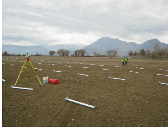
Figura 3.2.2.a. Trabajos topográficos. Fuente: Modificados de los Proyectos de Ejecución de las Plantas Fotovoltaicas Venta Angulo, Los Llanos y Las Canteras. TT.MM. Baza y Caniles (Granada).
