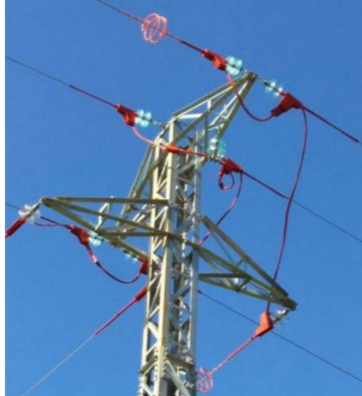
Figura 60. Forros avifauna (falta suspensión)
