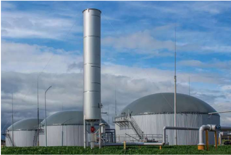
Antorcha de seguridad (Propio)
