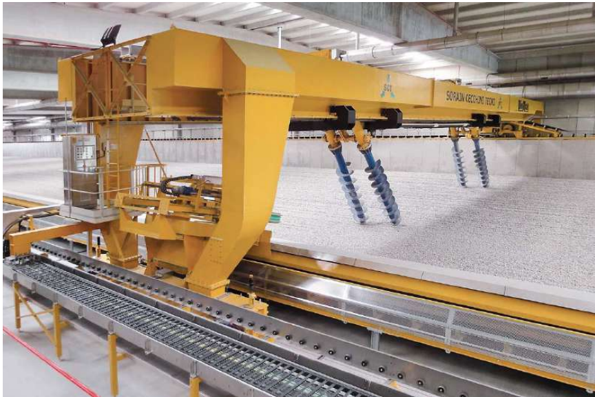
Instalación de compostaje
