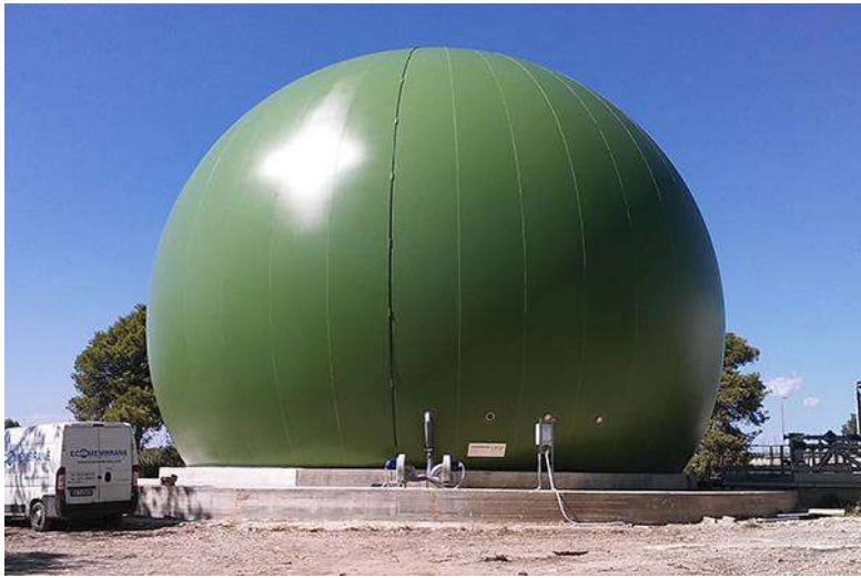
Membrana de almacenamiento de biogás
