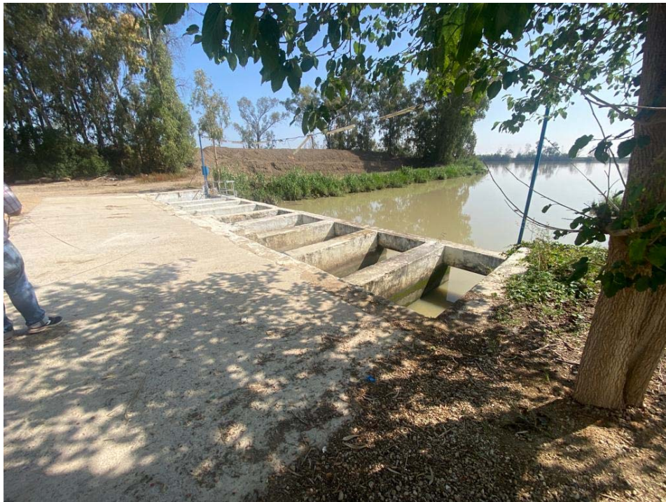
Obra Civil de Captación.
