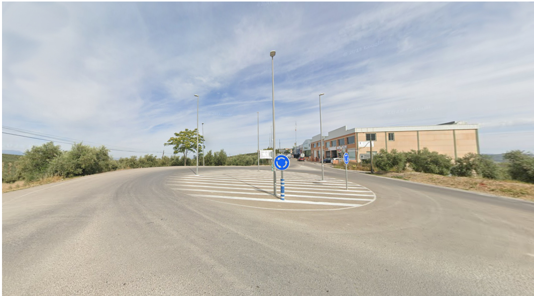
Vista de la rotonda donde finaliza el tramo de vía pecuaria deslindado y vial de entrada al polígono industrial.
