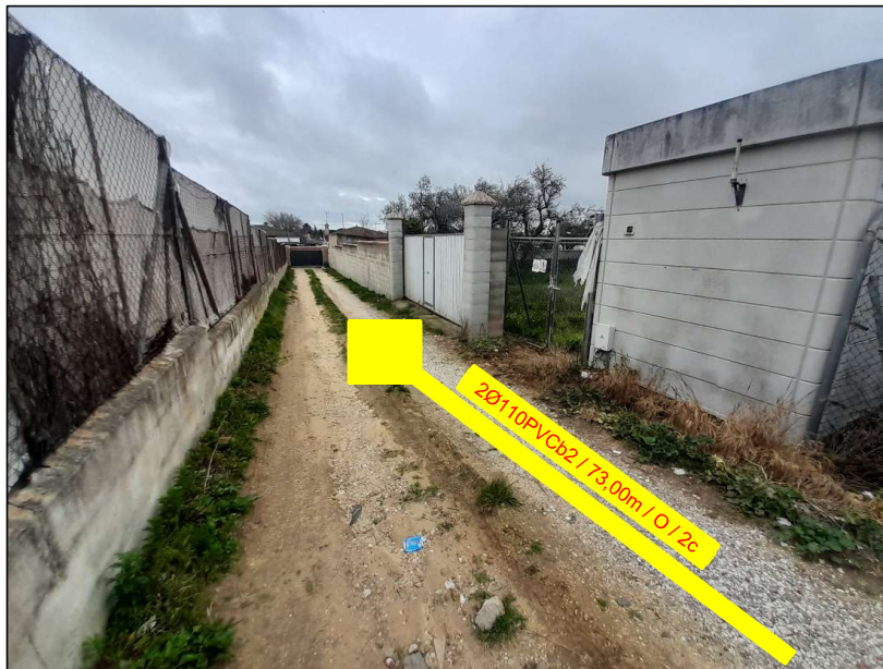
Imagen 10. Canalización por tierra
