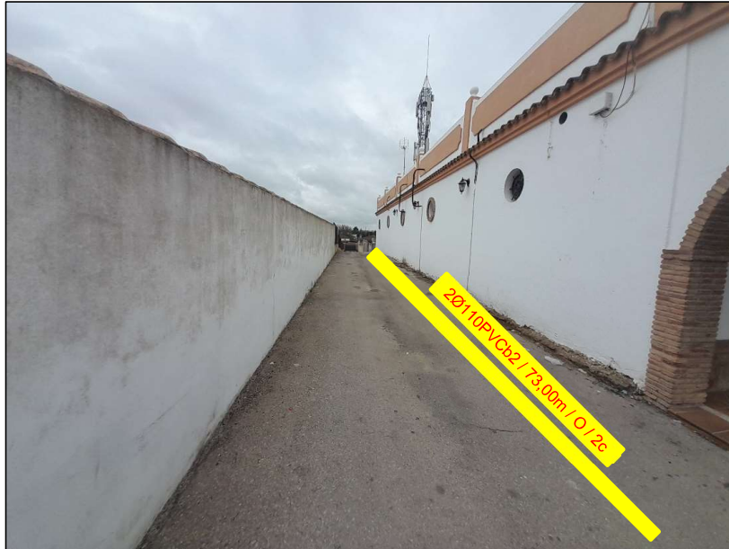
Imagen 7. Canalización por calzada
