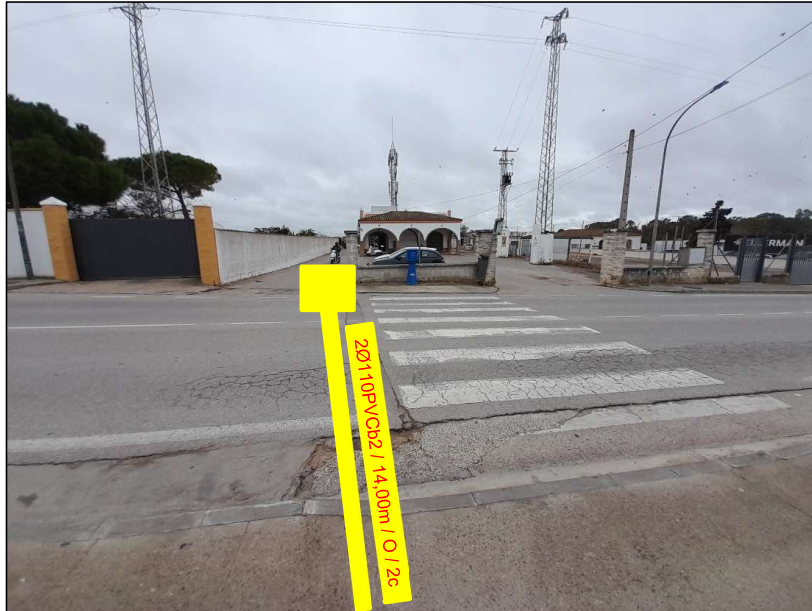
Imagen 5. Canalización por calzada
