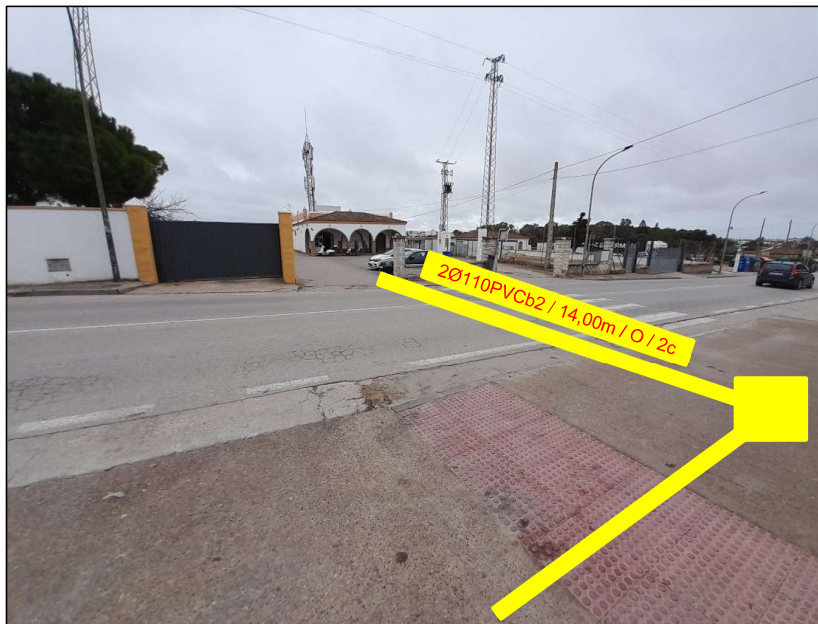
Imagen 4. Cambio a canalización por calzada
