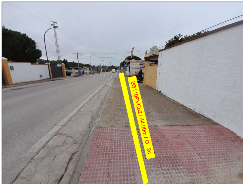
Imagen 2. Canalización por acera
