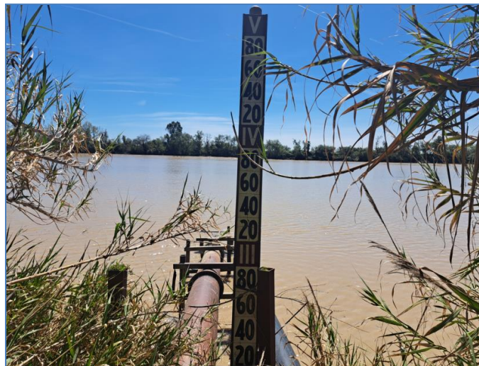
Figura 3. Captación en la margen derecha del río Guadalquivir
