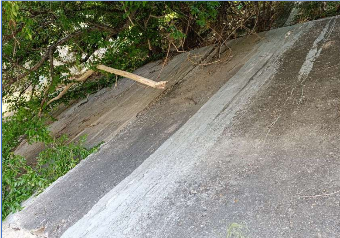
Figura 9. Revestimientos de hormigón en talud margen izquierda del río Guadalquivir
