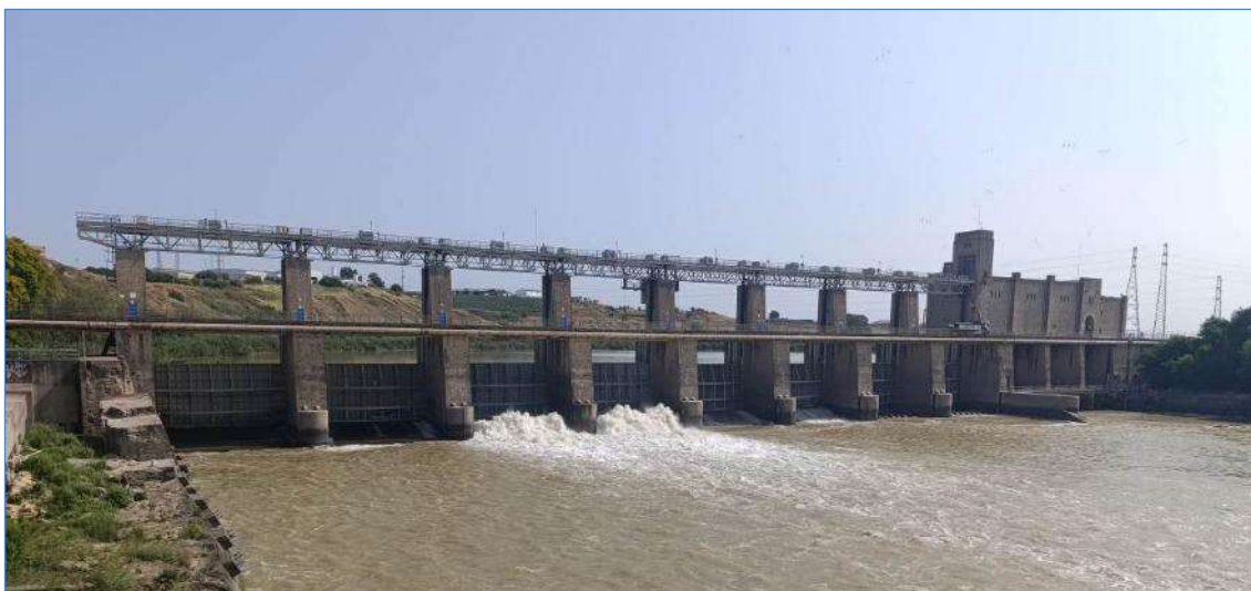
Figura 1. Situación de la central hidroeléctrica
