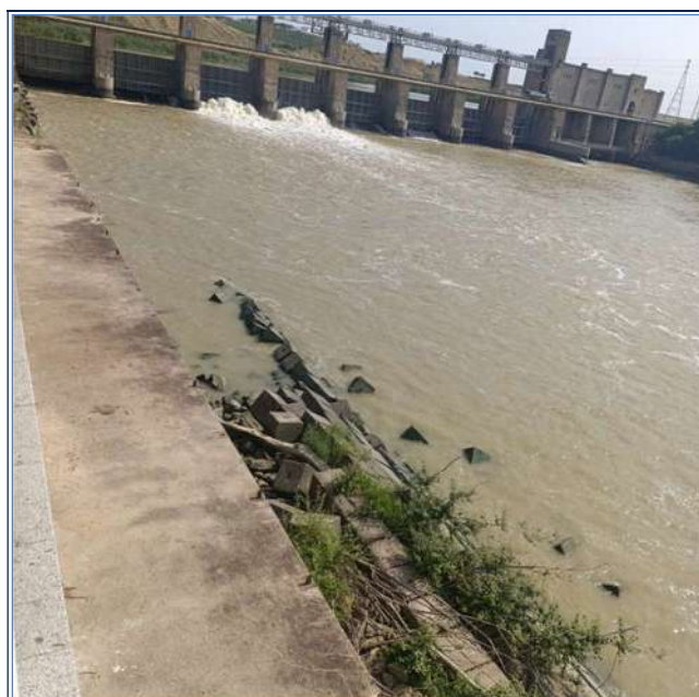
Figura 15. Muro de protección de hormigón en la margen derecha del río..
