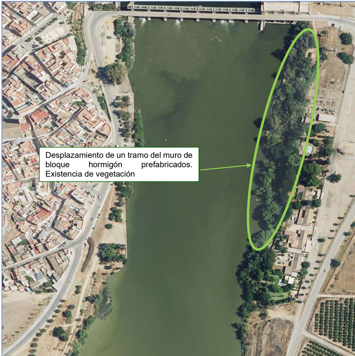
Figura 19. Ortofotografía del vuelo 2022. Situación actual margen izquierda en el entorno de la subestación
