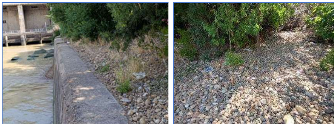
Figura 9. Entorno de la Central hidroeléctrica
