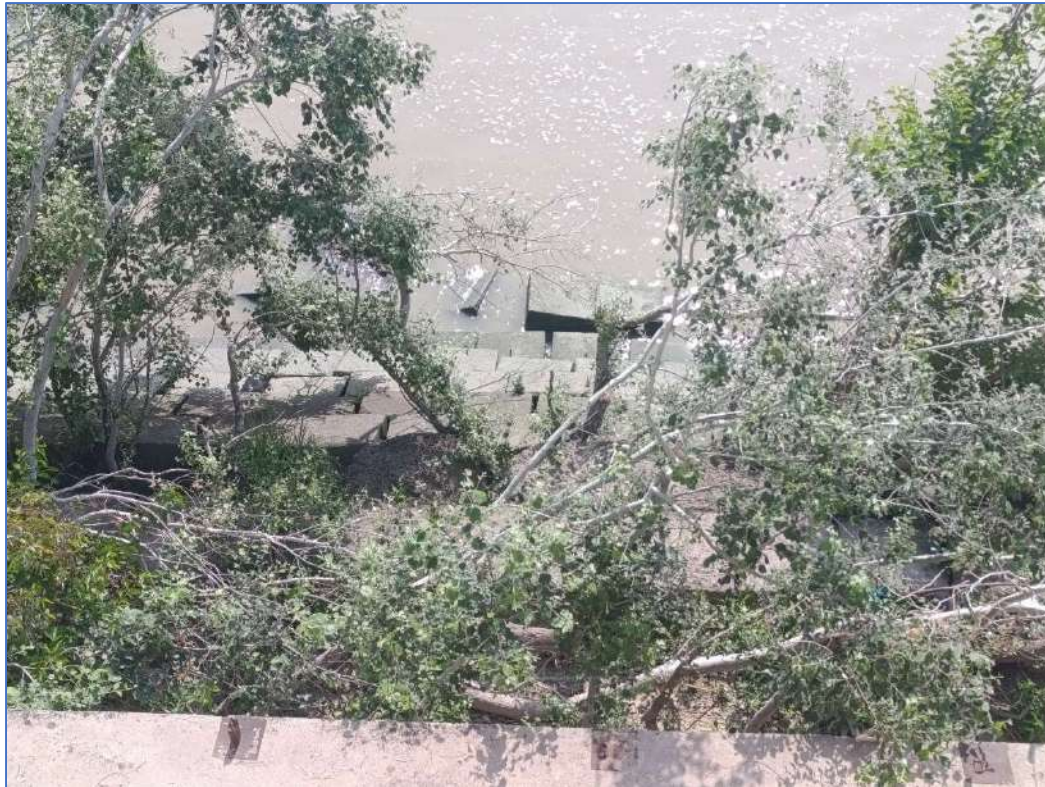
Figura 26. Prismas de hormigón del lecho del agua que fueron dispuestos para su protección y fueron desplazados a causa de las avenidas.
