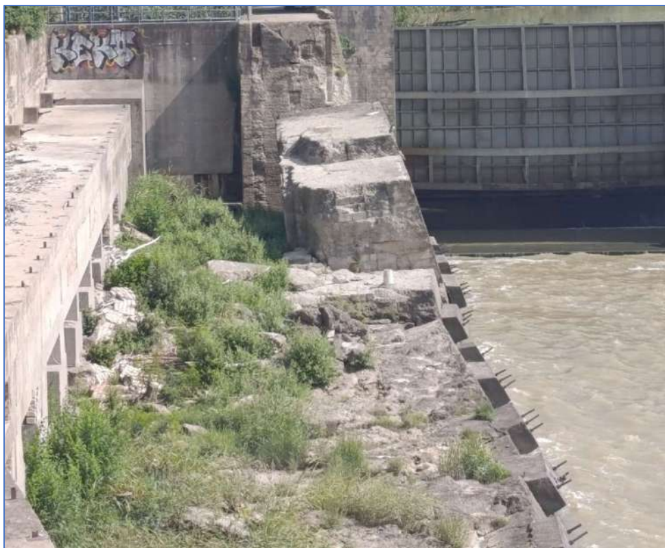
Figura 24. Muro de bloques de hormigón de protección deteriorado en la margen derecha
