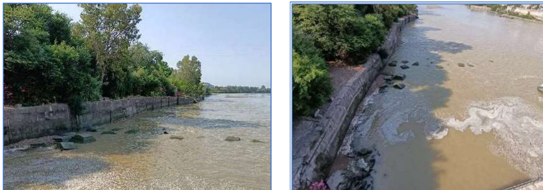
Figura 7. Elementos de protección del cauce de la central hidroeléctrica.
