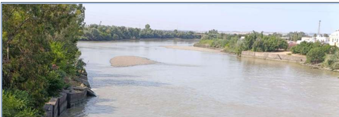
Figura 2. Acumulaciones de material de material erosionado en el lecho del cauce
