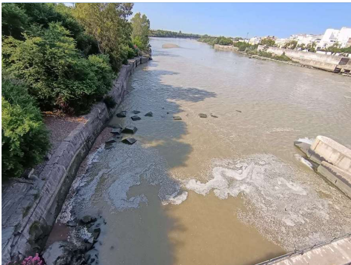
Figura 4. Canal de descarga de la central hidroeléctrica. Elementos de hormigón prefabricados
