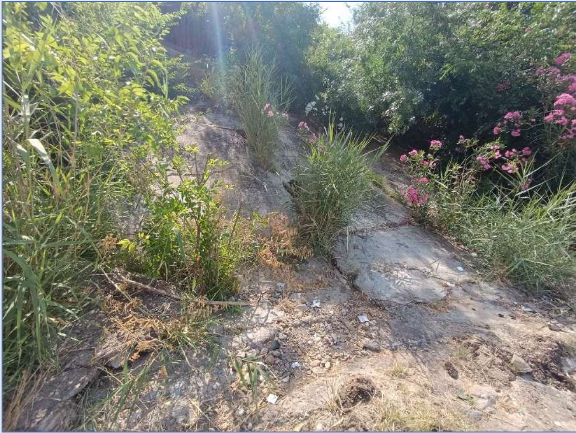
Figura 14. Taludes de hormigón fisurados en zona de actuación. Situación actual.
