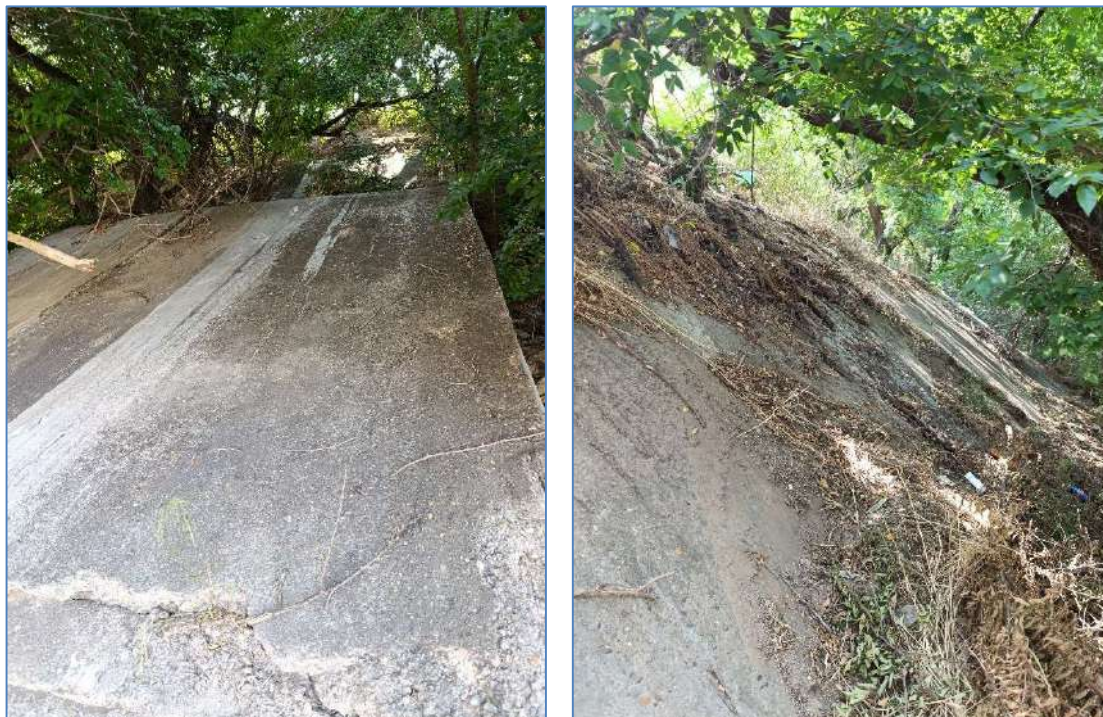
Figura 5. Revestimientos de hormigón en talud margen izquierda del río Guadalquivir.
