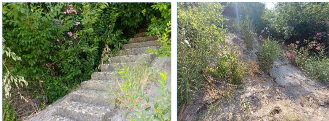
Figura 7. PK 0+070. Situación actual del talud de hormigón. Fragmentado con vegetación emergente de las fisuras.
