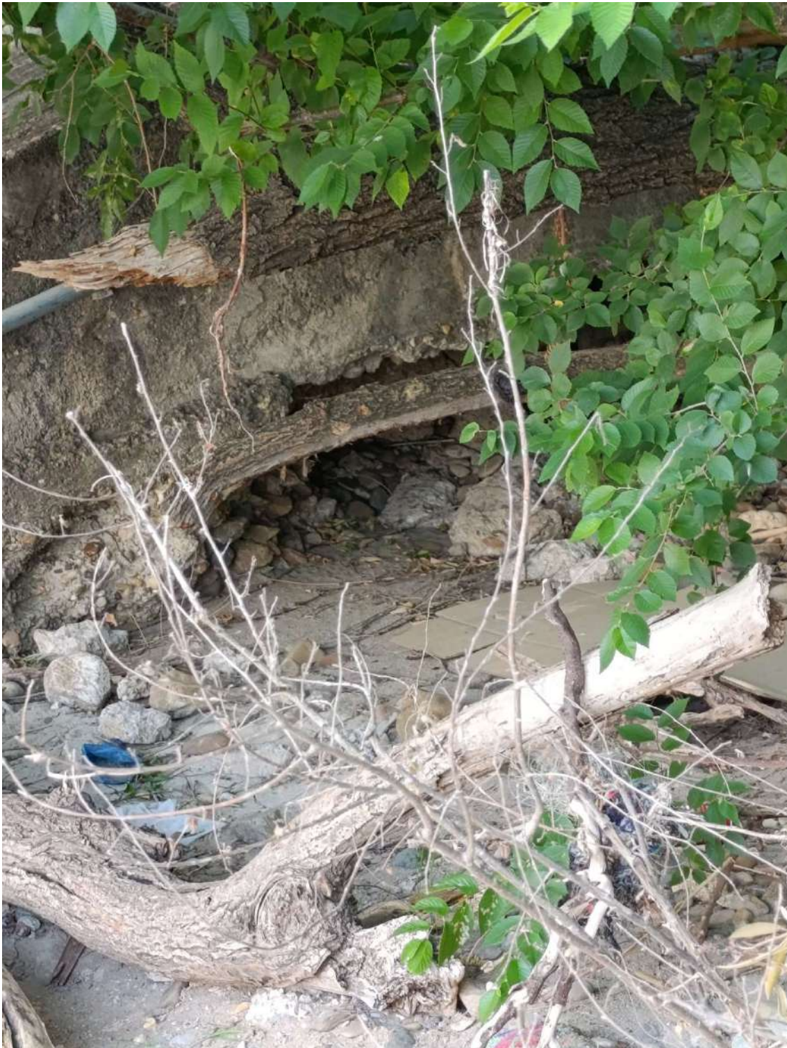
Figura 10. Revestimientos de hormigón en talud margen izquierda del río Guadalquivir
