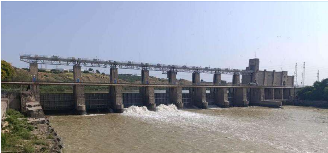
Figura 1. Situación de la central hidroeléctrica
