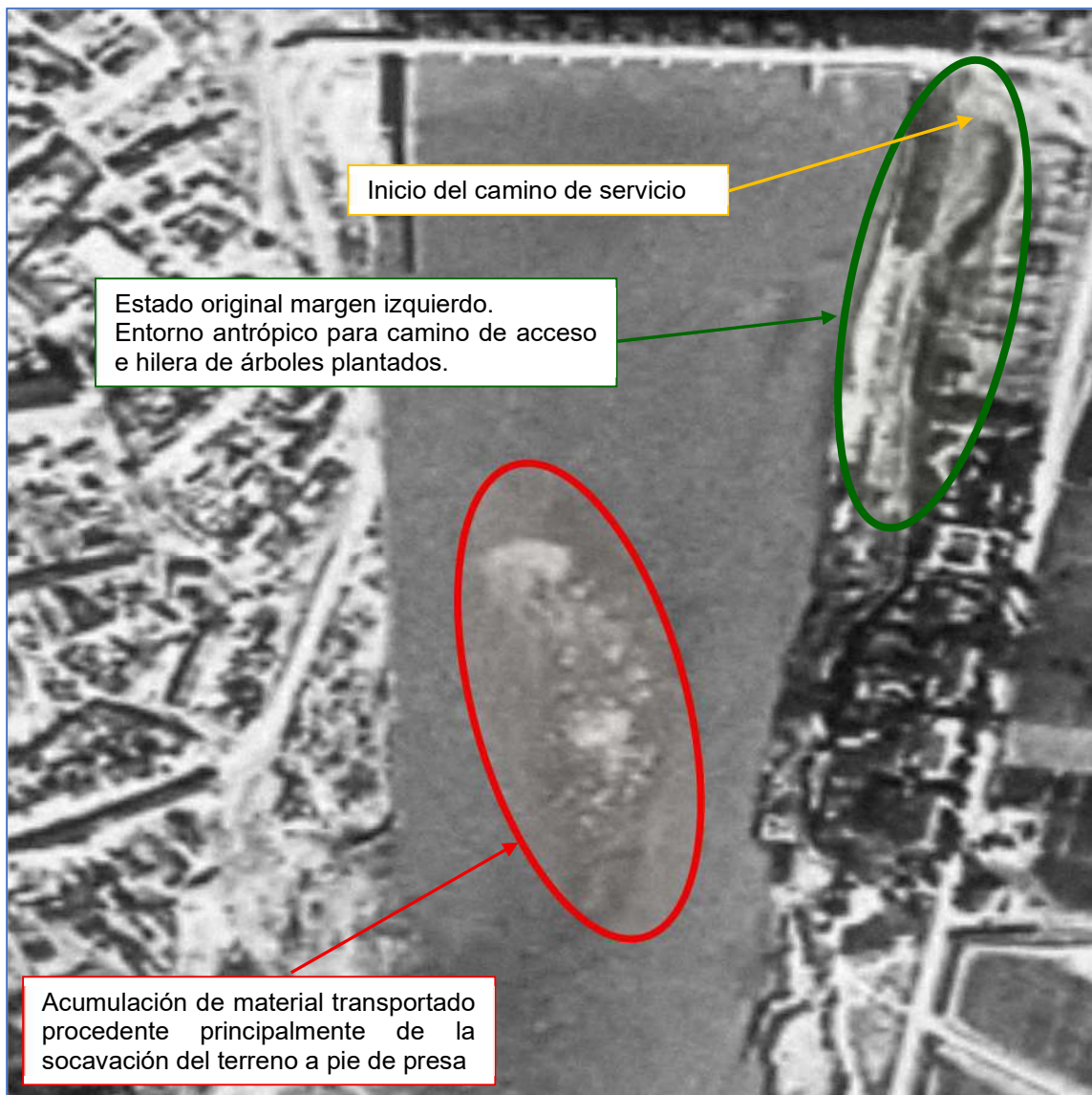
Figura 16. Ortofotografía de 1956-1957. Primera evidencia gráfica de la acumulación de sedimentos aguas abajo del cuerpo de presa debido a la socavación del lecho del cauce, así como del estado original de la margen izquierda del río.
