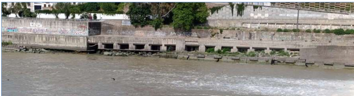
Figura 14. Prismas de hormigón del lecho del agua que fueron dispuestos para su protección y fueron desplazados a causa de las avenidas.
