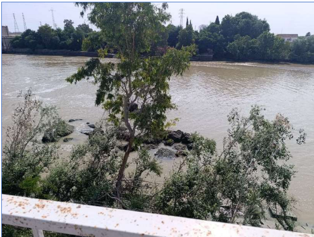
Figura 26. Prismas de hormigón del lecho del agua que fueron dispuestos para su protección y fueron desplazados a causa de las avenidas.
