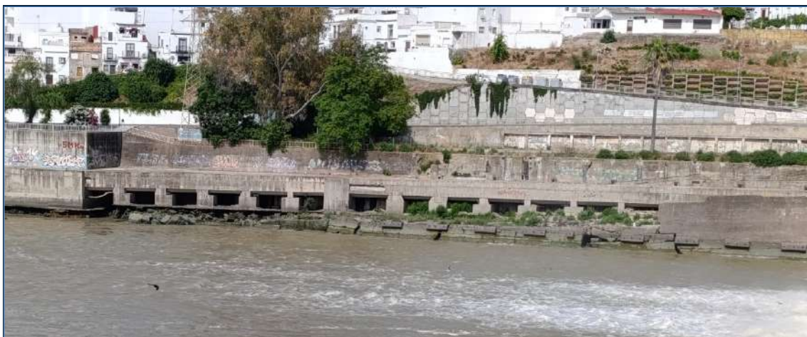
Figura 2. Estado actual de la margen derecha junto a zona de acopio
