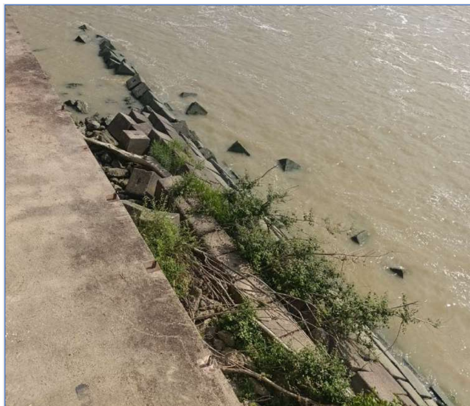
Figura 24. Muro de bloques de hormigón de protección deteriorado en la margen derecha
