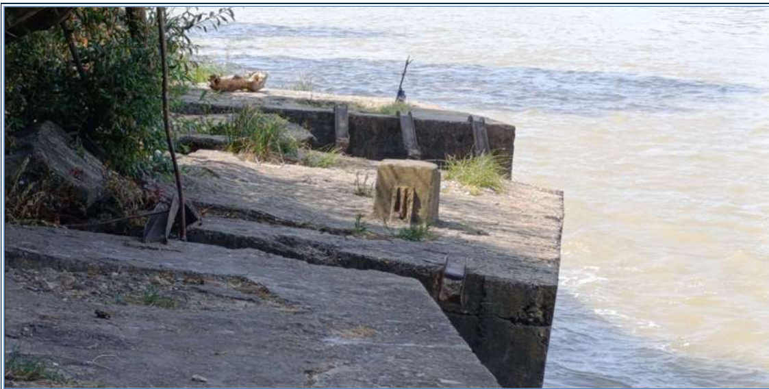
Figura 12. PK 0+070. Situación actual de los bloques de hormigón
