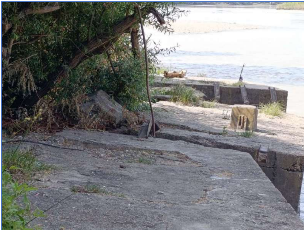
Figura 22. Canal de emergencia EMASESA, bulones y muro de protección
