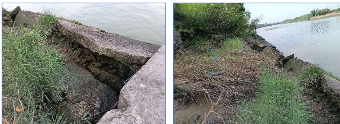
Figura 12. PK 0+070. Situación actual de los bloques de hormigón
