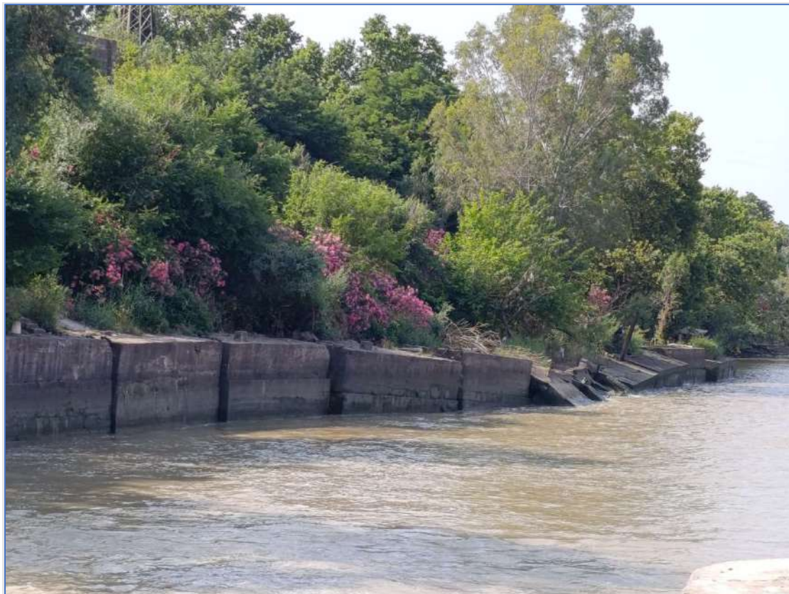
Figura 20. Muro de protección de la margen izquierda desplazado
