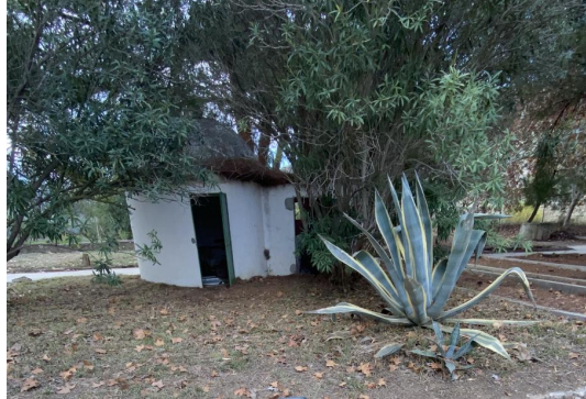
Foto de la caseta del pozo a regularizar
