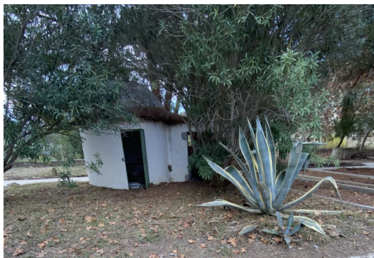
Foto de la caseta del pozo a regularizar
