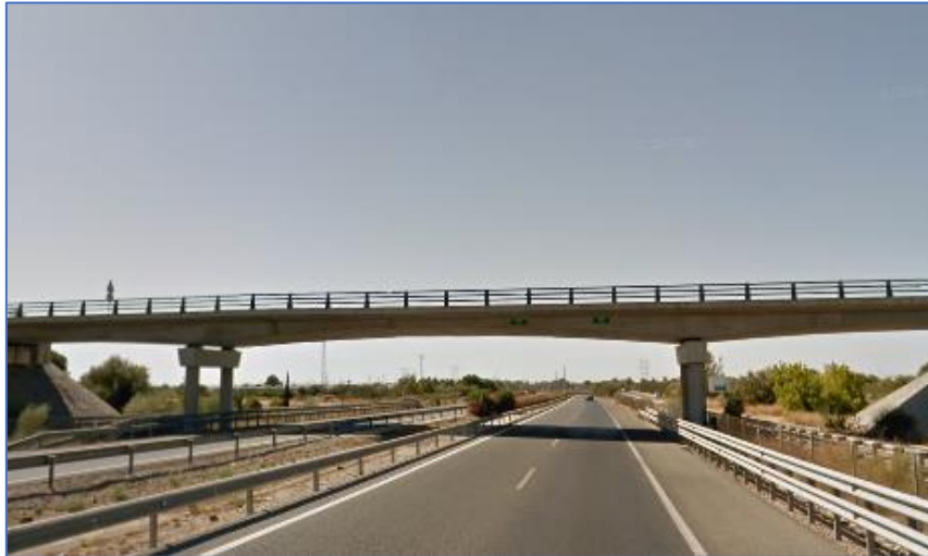
Figura 16. Puente de la autovía A-376.
