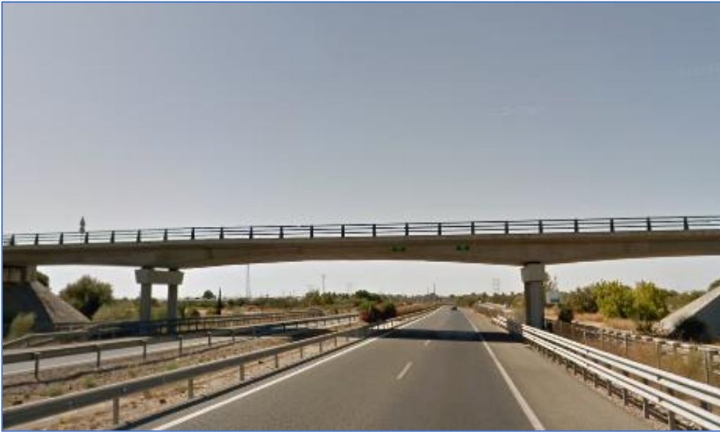
Figura 16. Puente de la autovía A-376.
