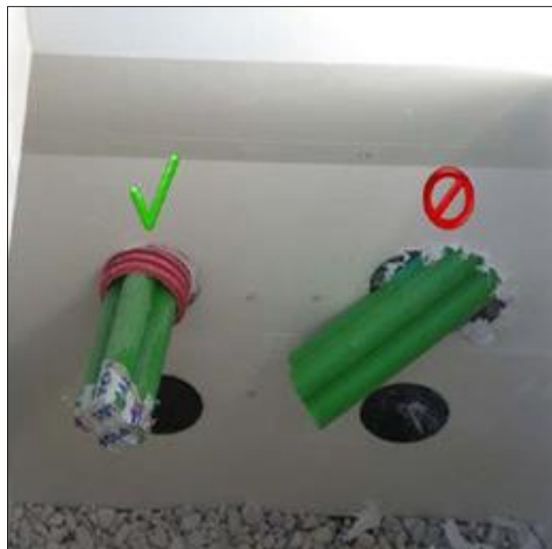
Ilustración 29. Entrada de tubos a la arqueta
