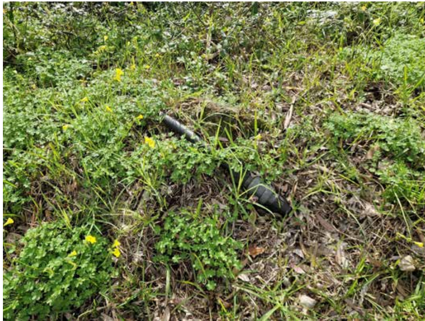
Tubería red de riego
