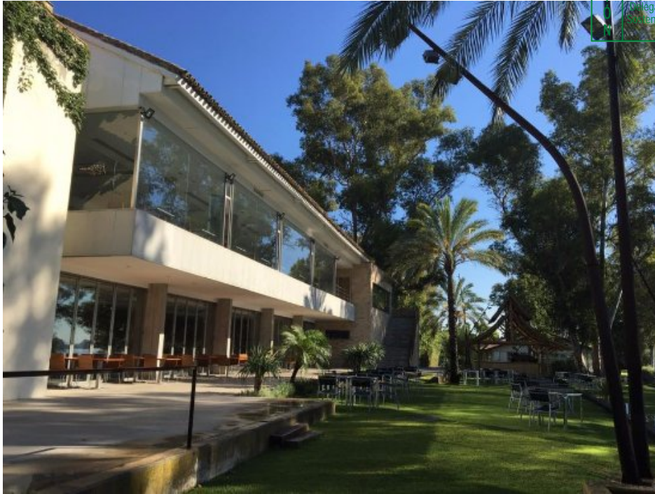
Fachada este del edificio restaurante-museo (volumen 1)
