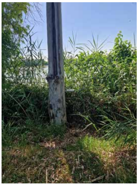
Instalación de alumbrado en árbol de rivera
