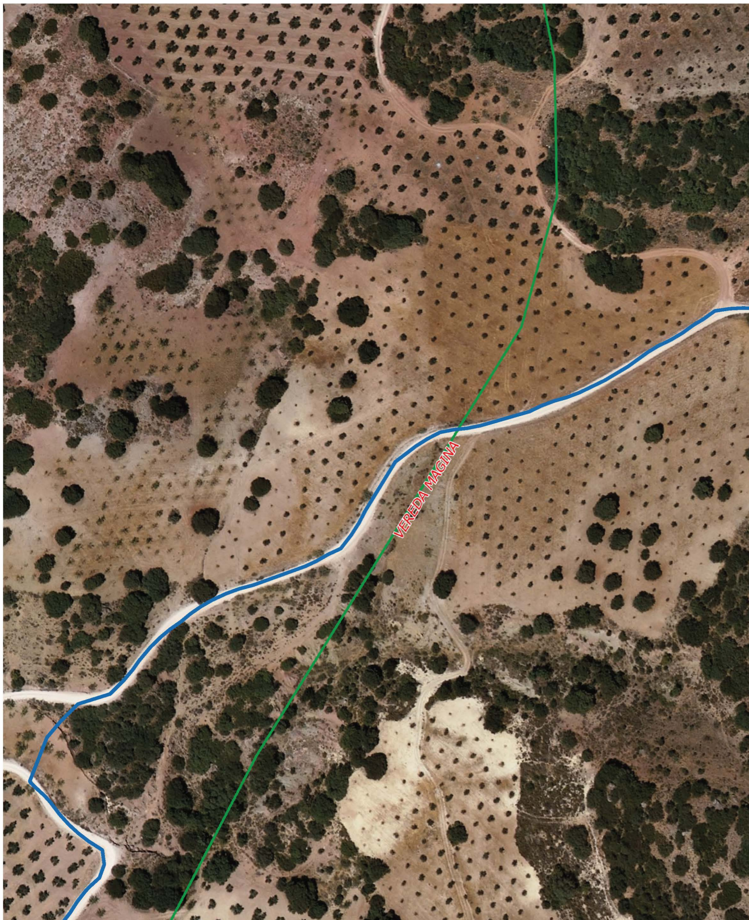
AFECCIÓN Nº1. CRUCE VEREDA
